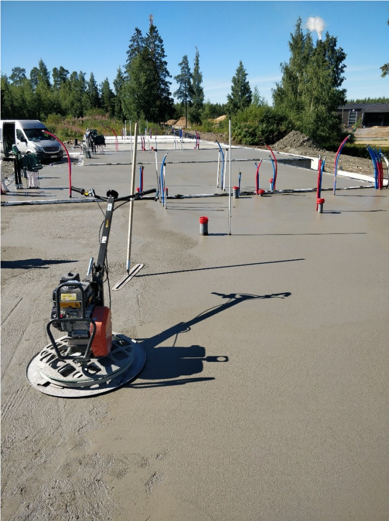
Kuva 9. Lattian pintojen tekoa hierrinkoneen sekä varsiliipan avulla (Kohtanen, 2023).
