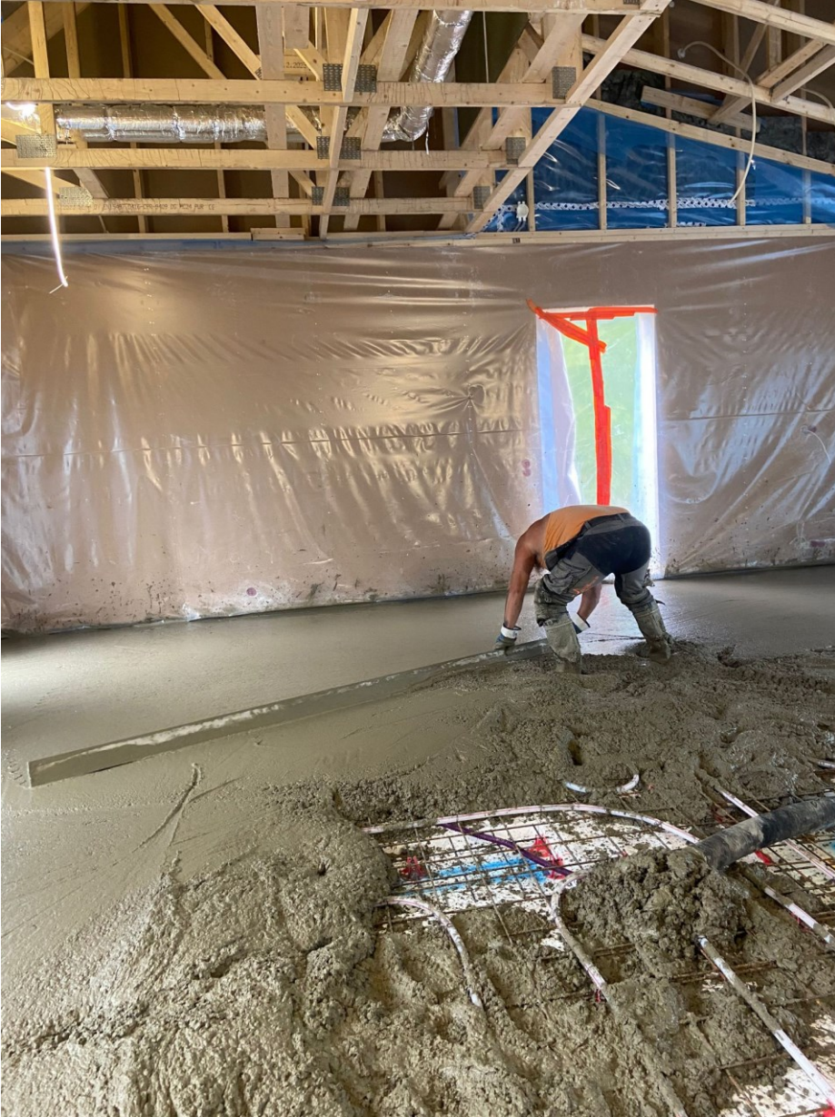
Kuva 3. Havainnollistava kuva betonin levittämisestä linjaarin avulla (Kohtanen, 2023).
