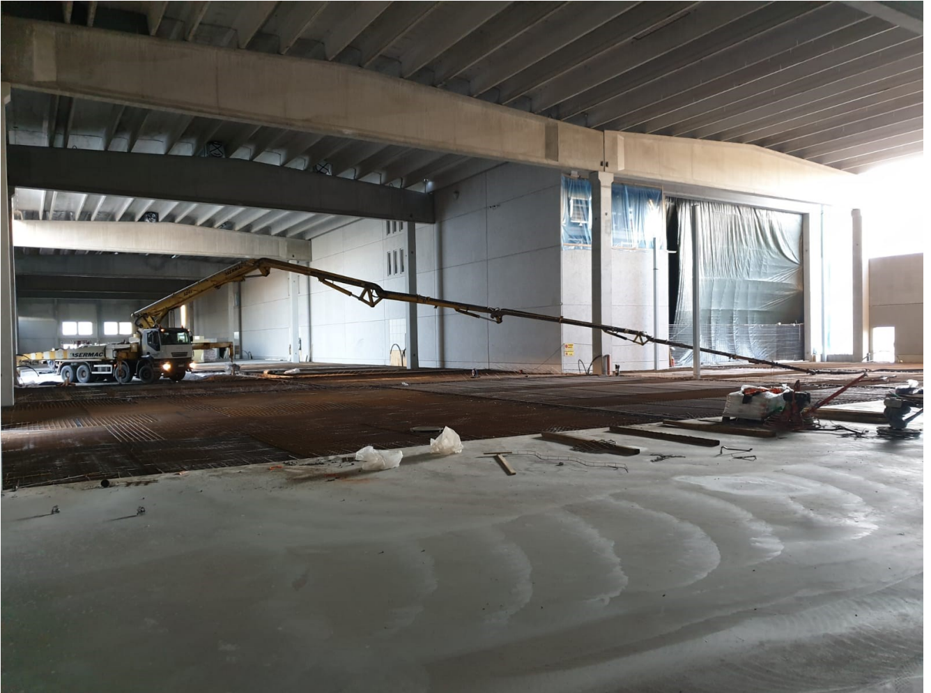
Kuva 7. Pumppuauto pystytettiin sisälle letkulinjan pituuden pienentämiseksi (Kohtanen, 2023).
