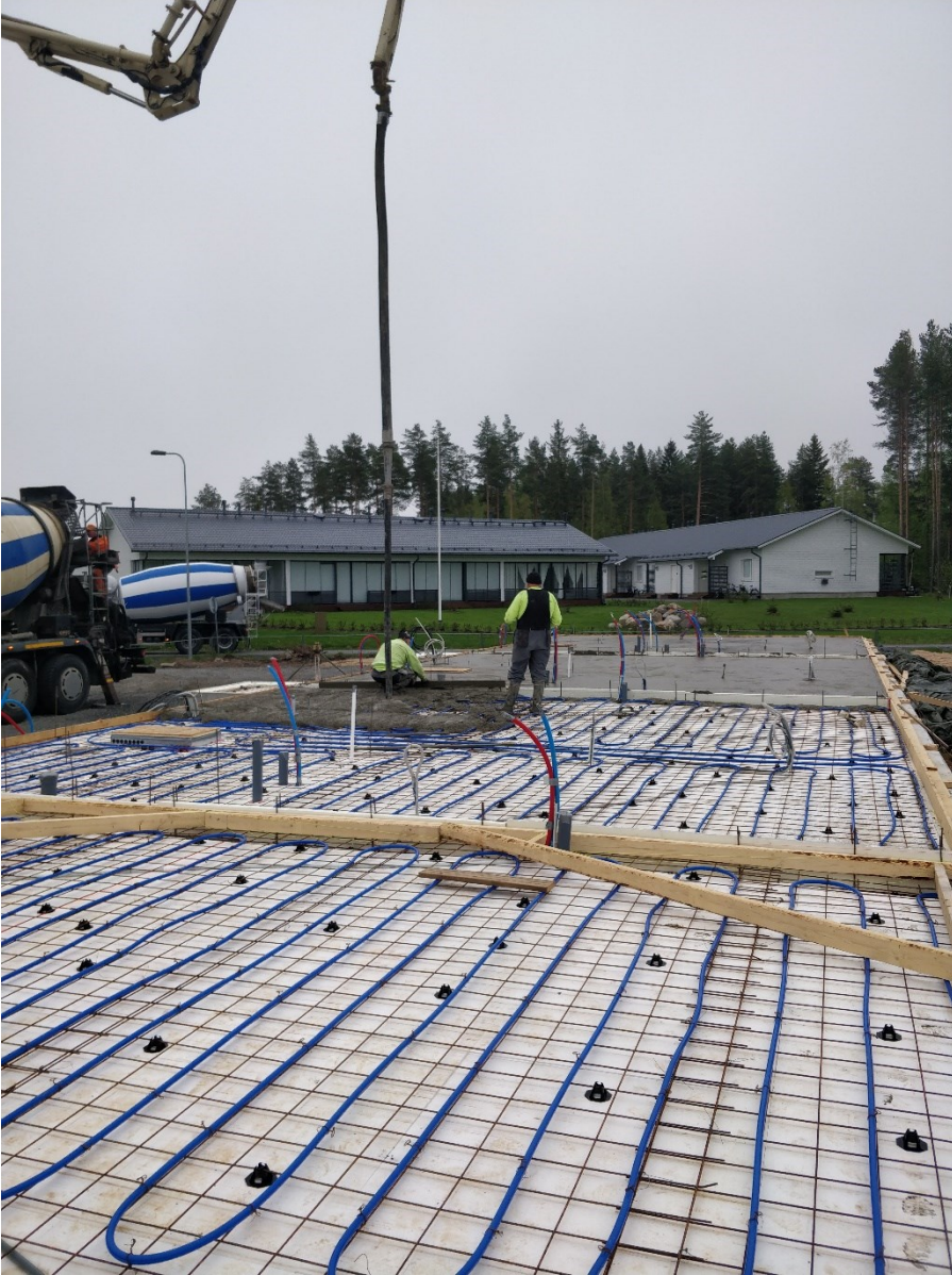
Kuva 1. Betonilattian valutyö (Kohtanen, 2023).
