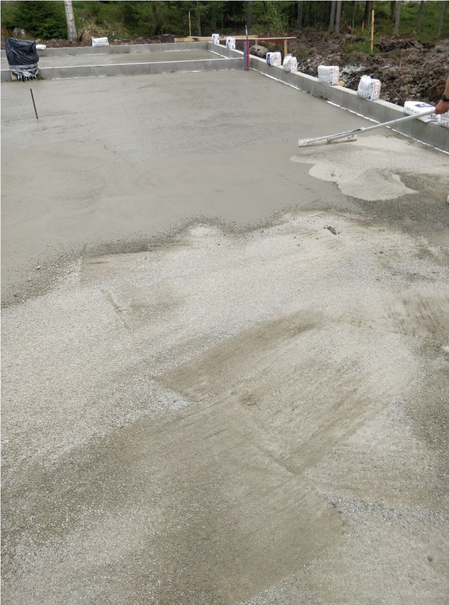
Kuva 13. Kuivasirotteen levittämistä kolan avulla (Kohtanen, 2023).
