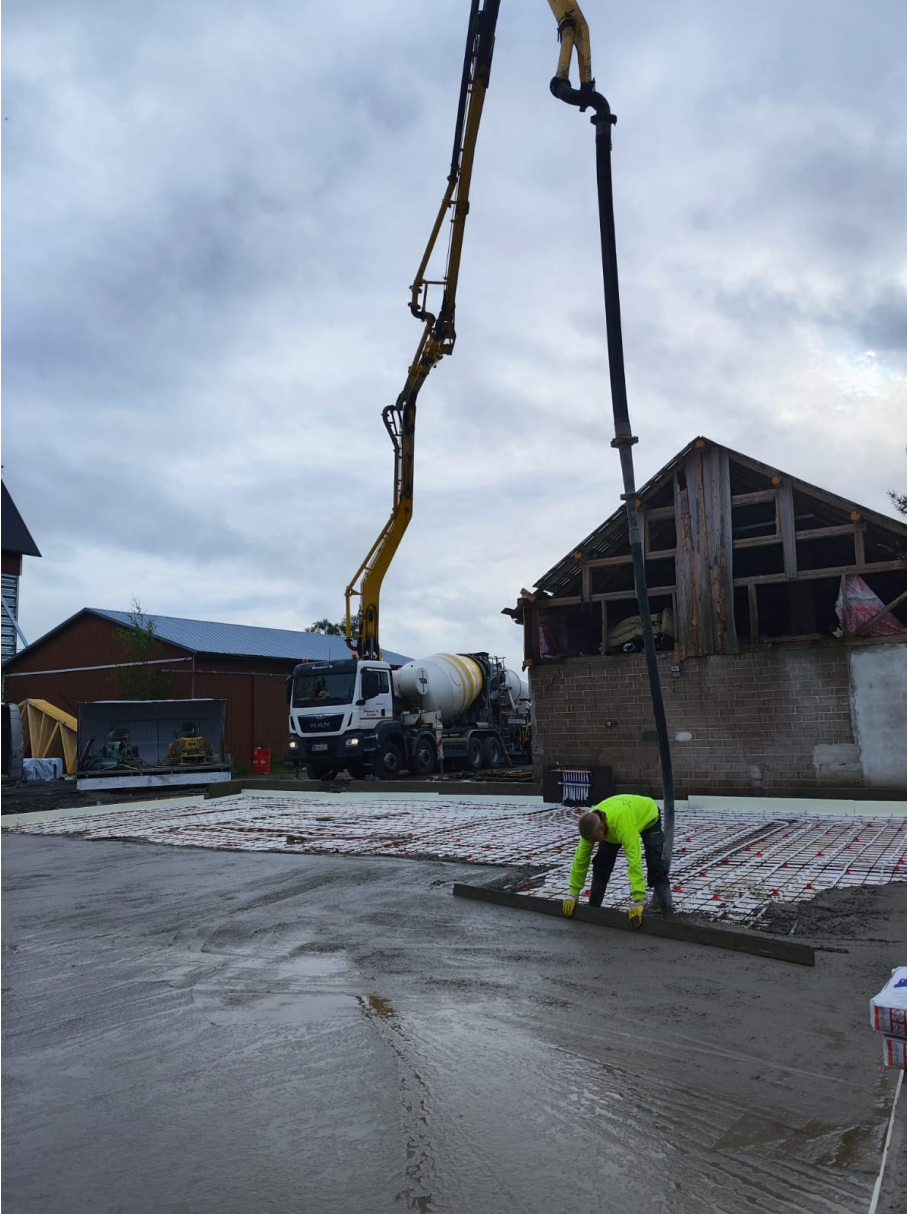
Kuva 2. Betonin levitystä linjaarilla (Kohtanen, 2023).
