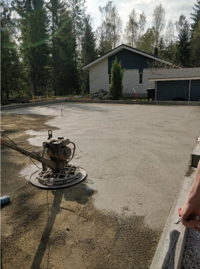
Kuva 11. Osa lattiasta hierretty hierrinkoneella kuivasirotteen levittämisen jälkeen (Kohtanen, 2023).
