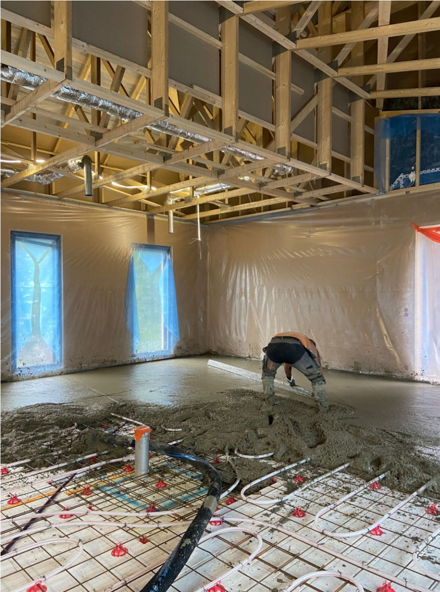
Kuva 4. Betonin levittämistä linjaarin avulla (Kohtanen, 2023).
