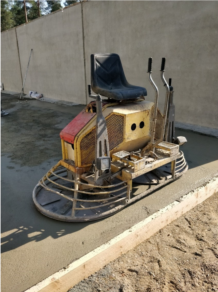
Kuva 10. Päättäjettava hierrinkone sirotelattiatyössä (Kohtanen, 2023).
