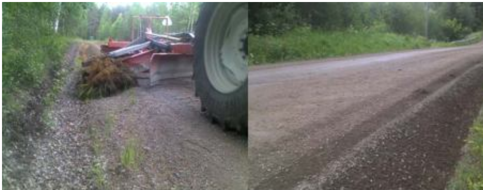
Kuva 6. Reunamateriaalin nostoa tielle lanalla (3, s. 49)
