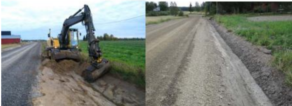
Kuva 7. Sivuojan kunnostusta ja kunnostettu sivuoja (3, s. 48)
