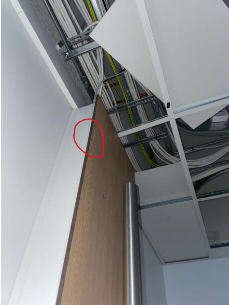
KUVA 22. Etulevyn hammastus korjattu uudella etulevyllä
