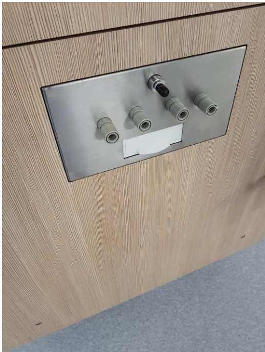
KUVA 26. Dialyysipaneelin RST-levy asennettuna rakennuttajan vaatimien korjaustoimenpiteiden jälkeen
