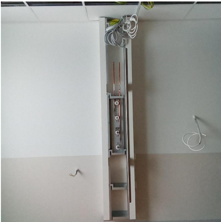
KUVA 9. Paneelirunko paikalleen asennettuna
