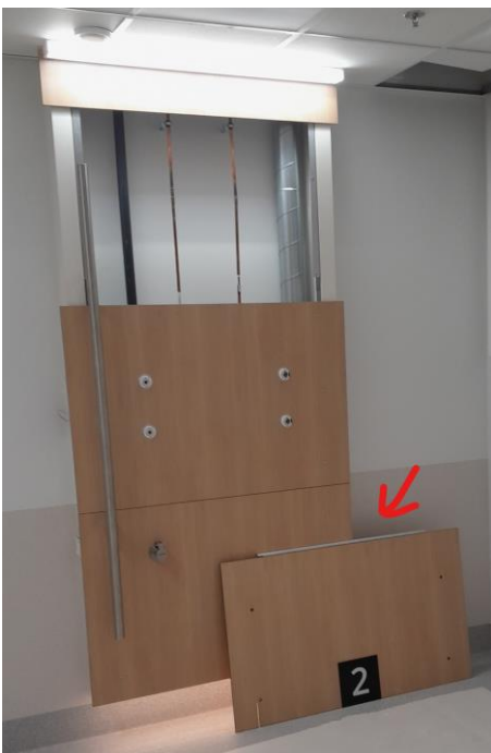
KUVA 23. Etulevyn pullotuksen korjaukseen käytetty kisko.
