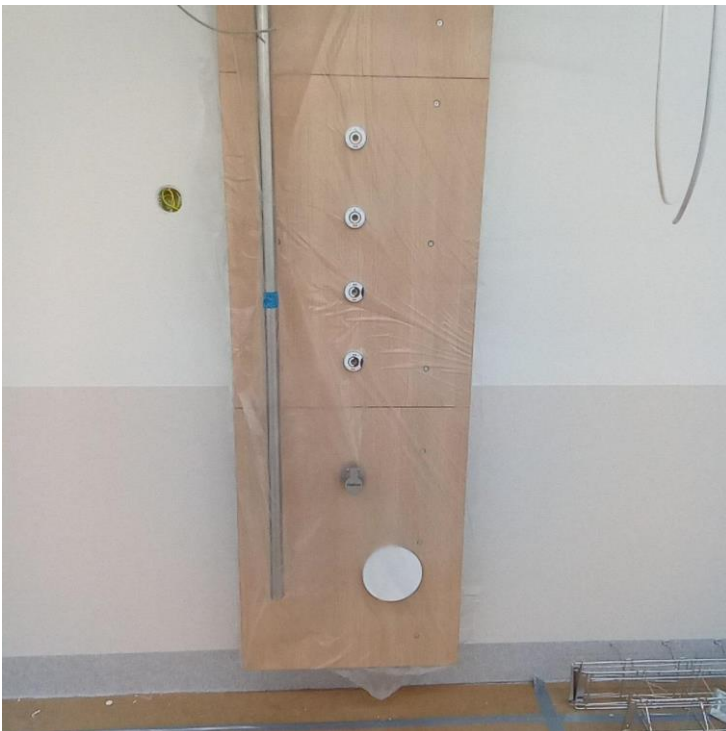
KUVA 11. Tyypin 12 paneeli valmiiksi asennettuna ja suojattuna
