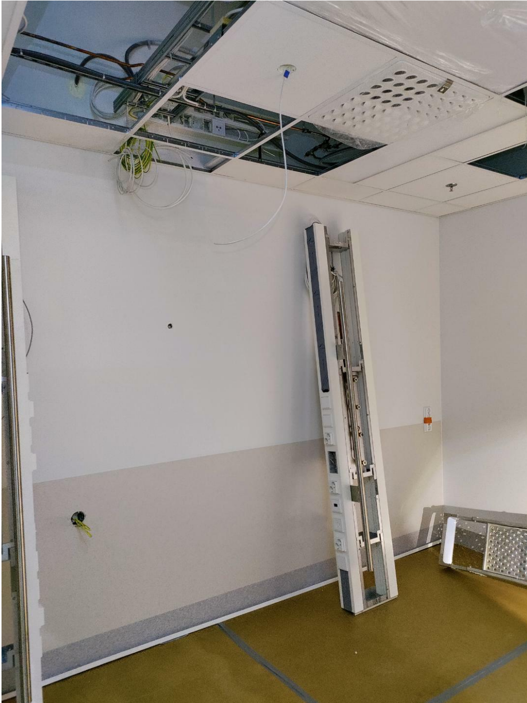
KUVA 7. Paneeliasennukset alkamassa valmiilla mestalla
