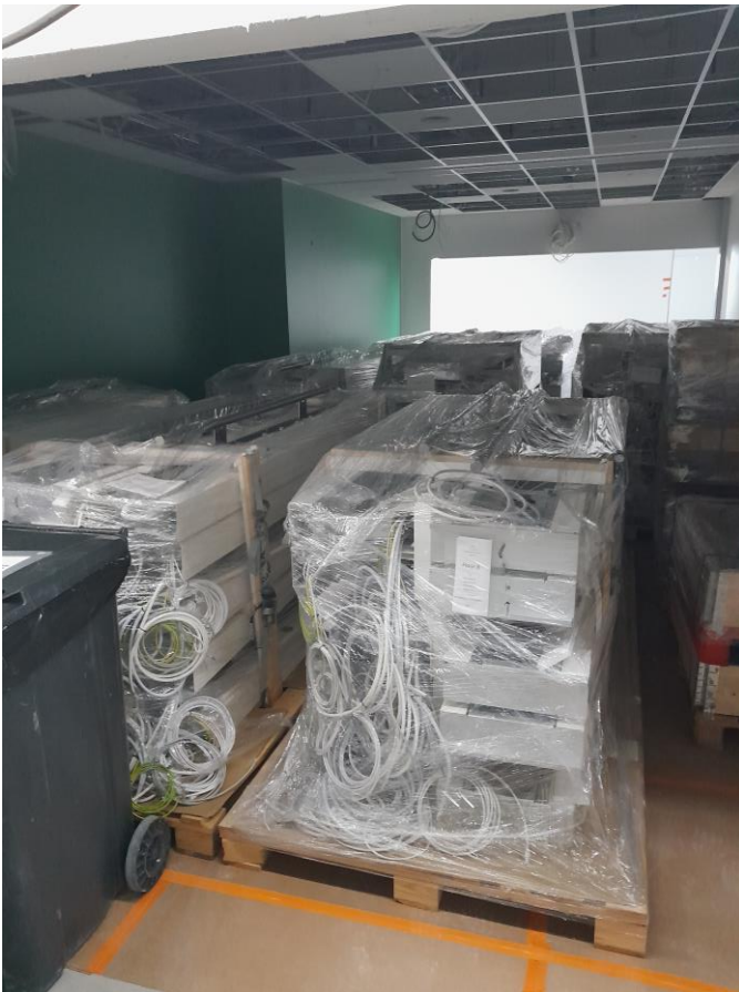
KUVA 6. Kerroksen paneelikuorma kerroksessa muoveilla suojattuna
