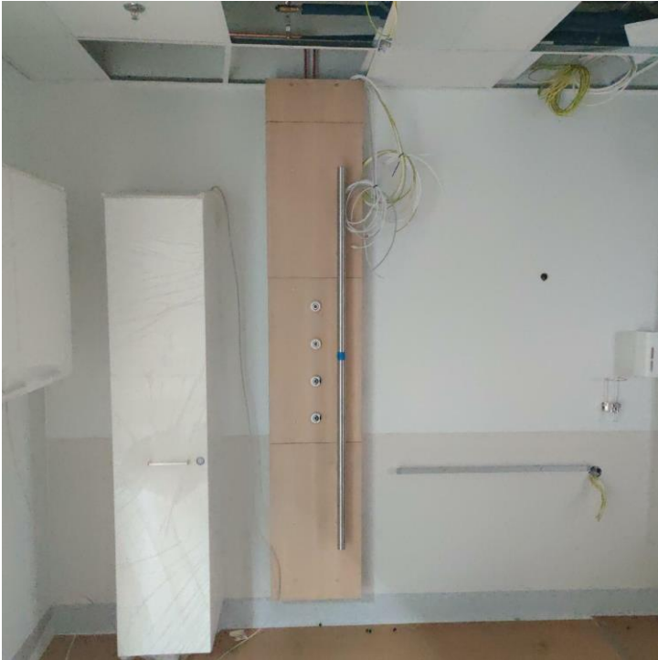
KUVA 10. Paneelin etulevyt asennettuina
