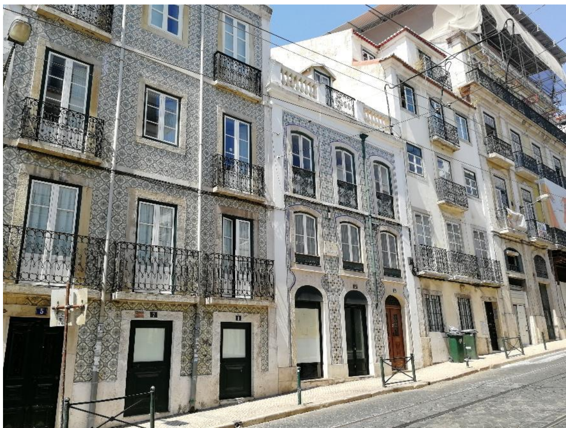
KUVA 6. Portugalilaisia laattajulkisivuja Lissabonissa (Pusa 2018)
