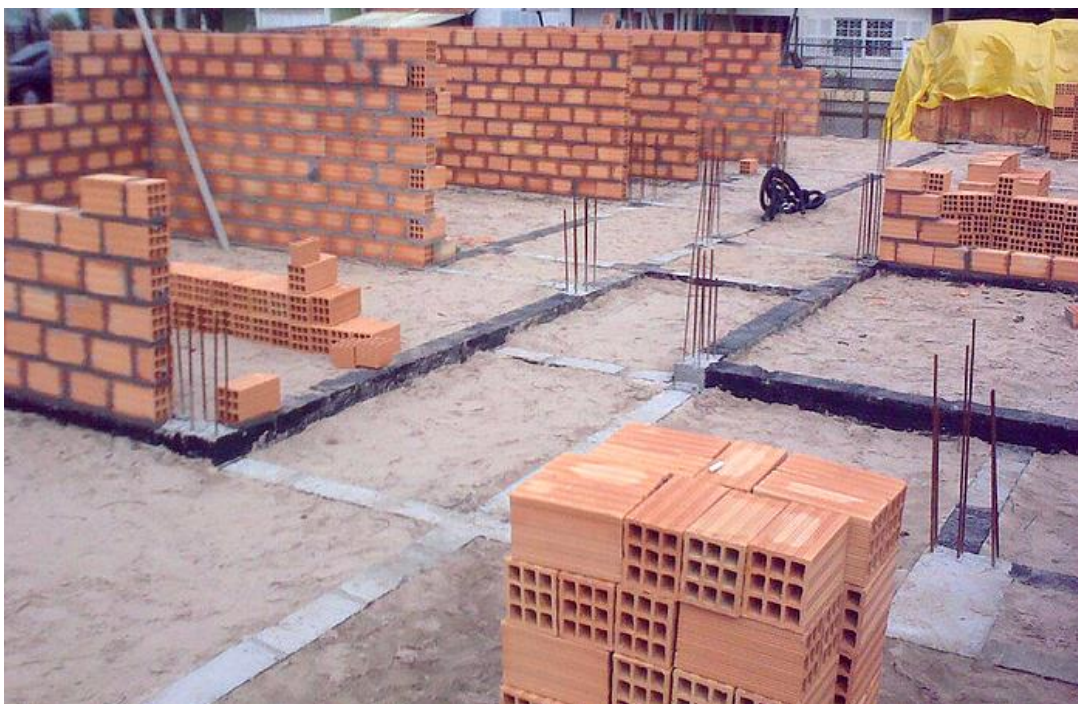
KUVA 10 Yhdentyypisiä ontelotiiliä asuinrakennuksen rakennustyömaalla Brasiliassa (rduate 2009, CC-BY-NC-SA 2.0 , Flickr, muokattu)
