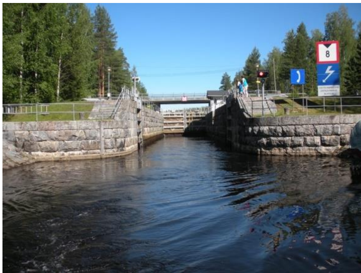
KUVA 2. Lastukosken sulku (Manninen 2014-07-06.)
