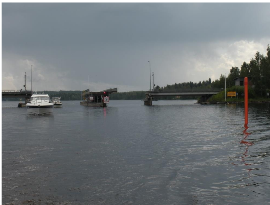
KUVA 7. Jännevirran silta (Manninen 2014-07-04.)
