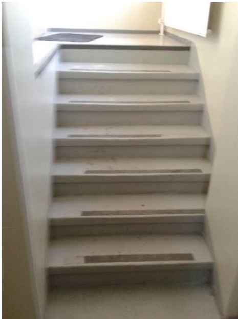
Figur 16. Trappa upp till tegelbyggnadens andra våning.
