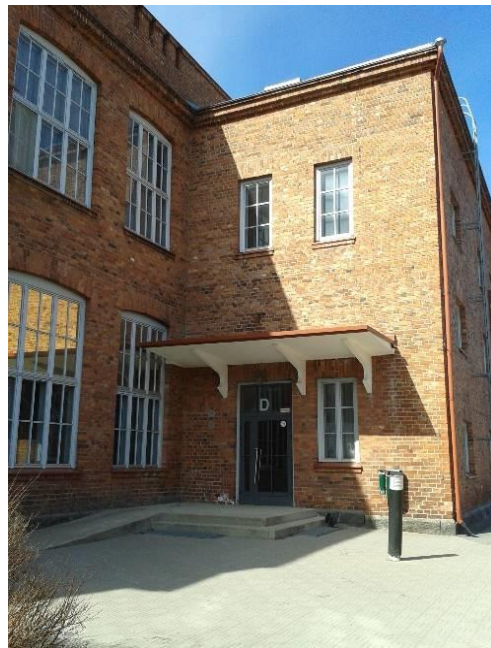
Figur 12. Tegelbyggnadens fasad, fönster och entré.
