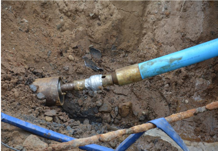
KUVA 3. Pakkosujutus Robust RC-paineputkella (Pipelife n.d.).
