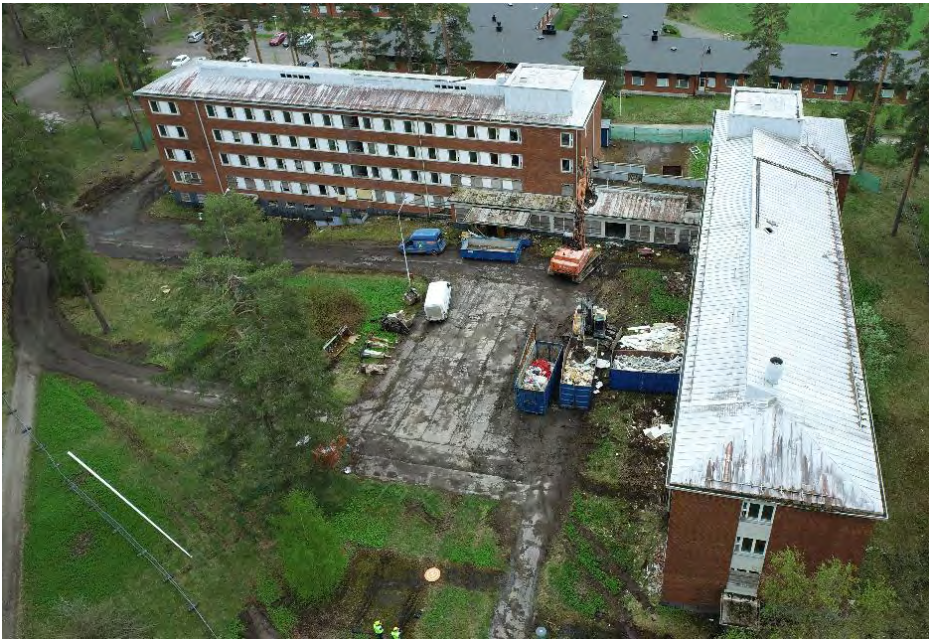
Kuva 2. Ilmakuva Tuukkalan sairaalan purkutyömaasta (kuva Juha Vihavainen 2021).
