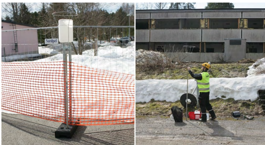
Kuva 11. Laskeumakeräimen asennusta Pankalammen purkutyömaalla (kuva Juha Vihavainen).
