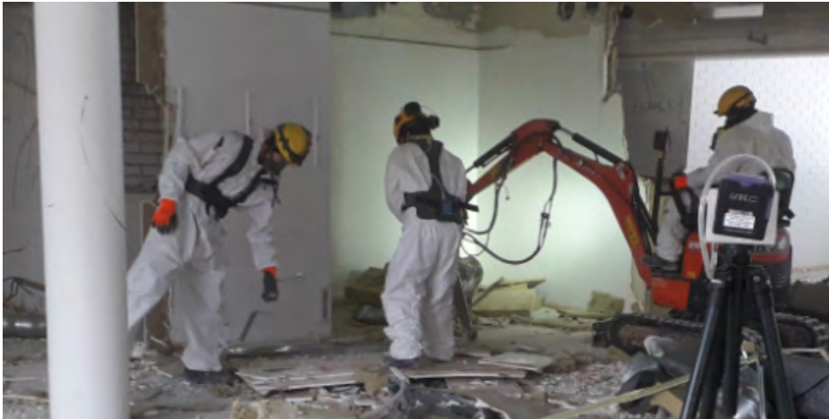
Kuva 3. Sisäpurkua ja lajittelua Bobcatin avulla Pankalammen työmaalla (kuva Juha Vihavainen).
