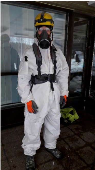
Kuva 8. Suojavarusteisiin pukeutunut purkutyöntekijä henkilökohtaisen hengittävän pölyn mittarilla varustettuna (kuva Sari Seppäläinen 2021).
