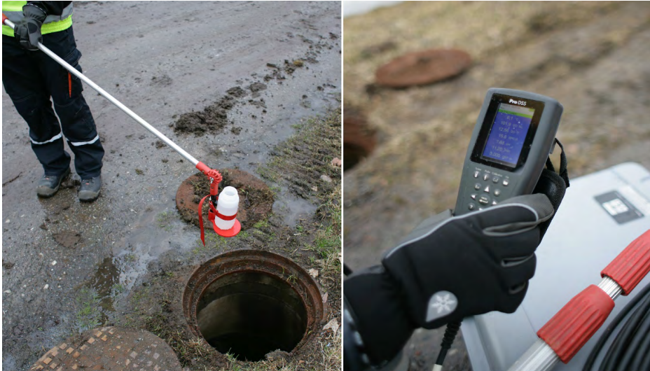
Kuva 2. Vesinäytteenottoa Pankalammen purkutyömaalla. Vasemmalla vesinäytteenotto ja oikealla Ysi ProDSS -monitorointia (kuvat: Juha Vihavainen).
