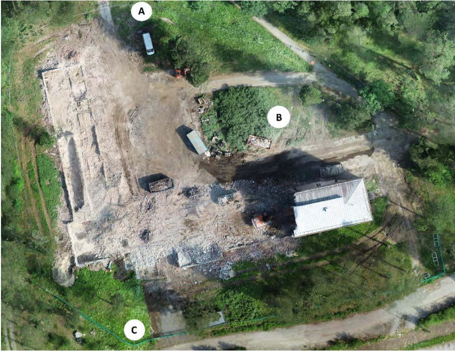
Kuva 12. Laskeumakeräinten sijoituspaikat A, B ja C Tuukkalan purkutyömaalla (kuva Juha Vihavainen 2021).
