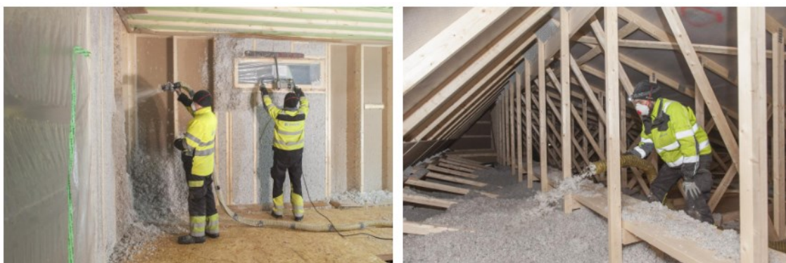
Kuva 4. Puhallusvillaa asennetaan. (Puuinfo, 2022)
