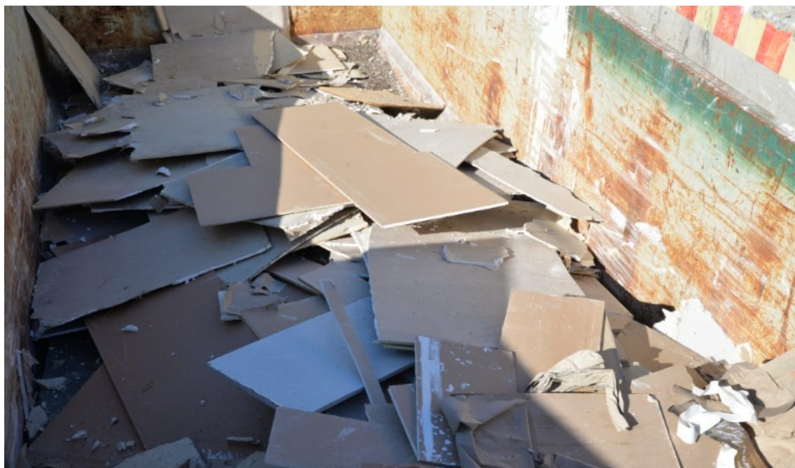
Kuva 3. Kipsilevyjätettä vaihtolavalla. (Mustankorkea, 2023)
