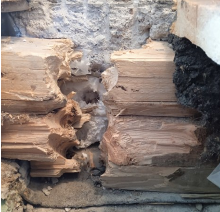
Kuva 19. A-osan ja kylpyhuoneen välinen rakenneavaus
