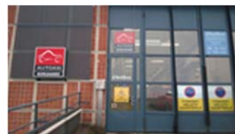
6) Korjaamon ulko-ovelle tulo
