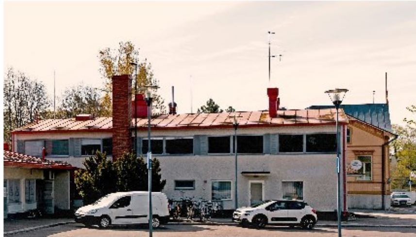
Kuva 15. Korkea osa pohjoiseen
