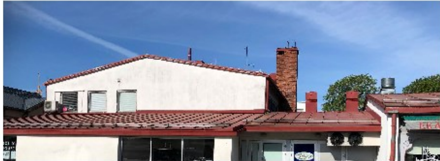
Kuva 11. Idän puoleisia vesikattovarusteita
