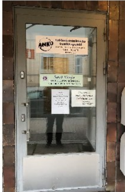
Kuva 7. Porraskäytävän ovi (etelään)
