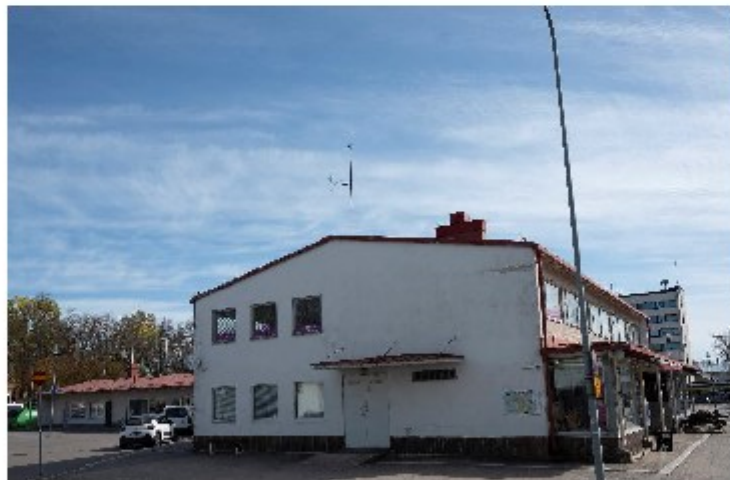
Kuva 13. Korkea julkisivu länteen
