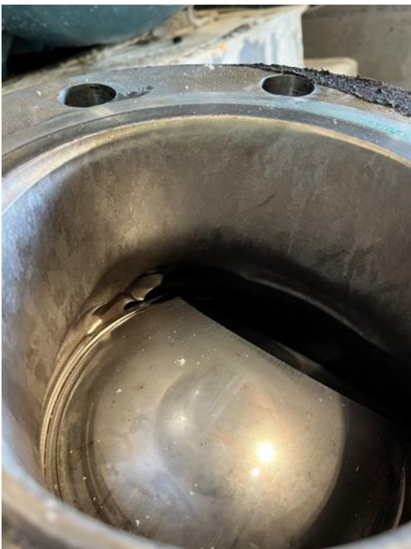
Kuvio 19. Vaurioitunut venttiilin runko
