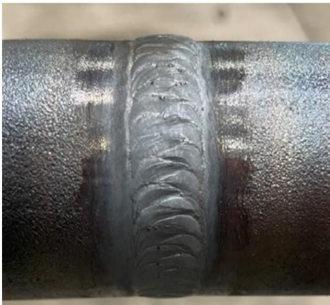
Kuva 29. Valmis putkien päittäisliitos hitsi (Kuva: Joni Kräkin)
