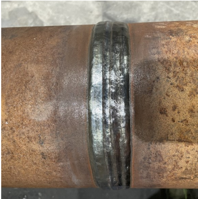
Kuva 15. Painelaiteosan hitsi valmistettu TIG- ja MAG yhdistelmä hitsauksella (Kuva: Joni Kräkin)
