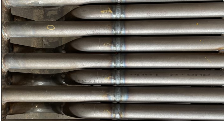
Kuva 24. Voimalaitoskattilan osa, jossa putkien päittäisliitokset valmistettu käsin hitsaamalla (Kuva: Joni Kräkin)
