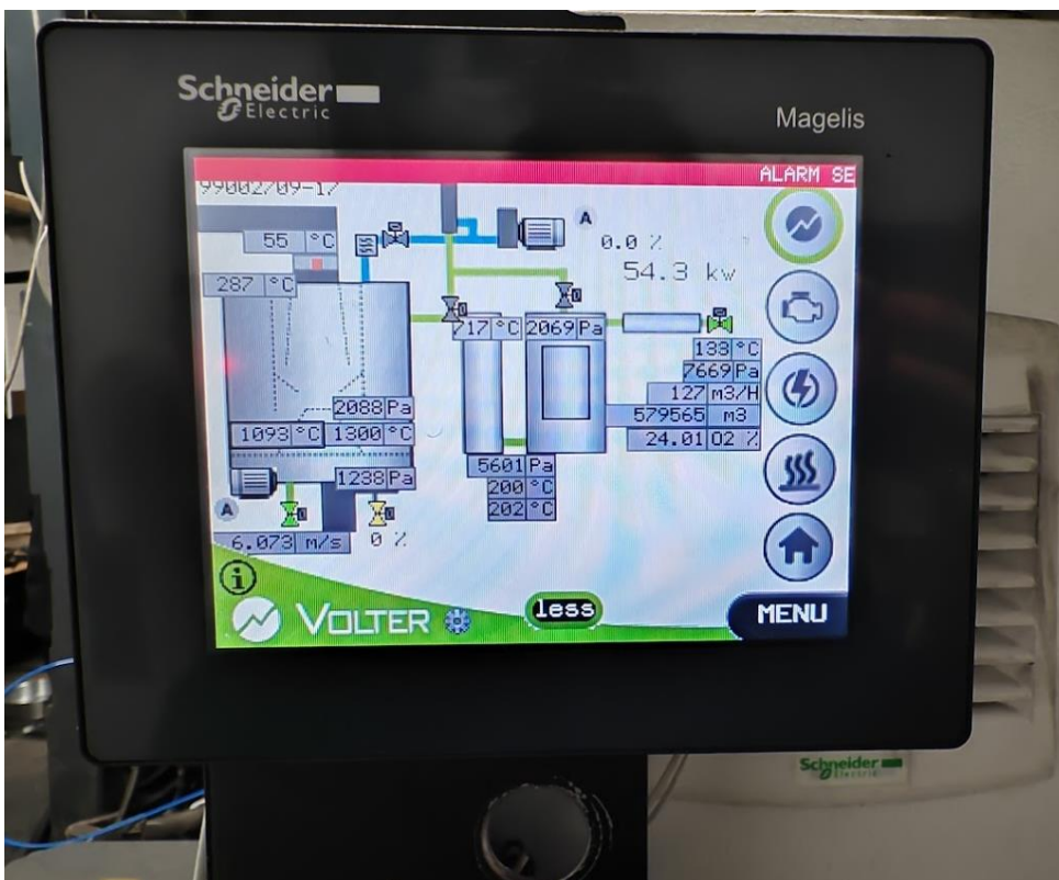
KUVA 3. Walter-voimalaitoksen kosketusnäyttölinen ohjauspaneeli
