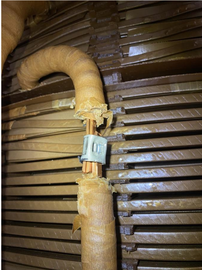
Kuva 11. Yläjännitepuolen liitos
