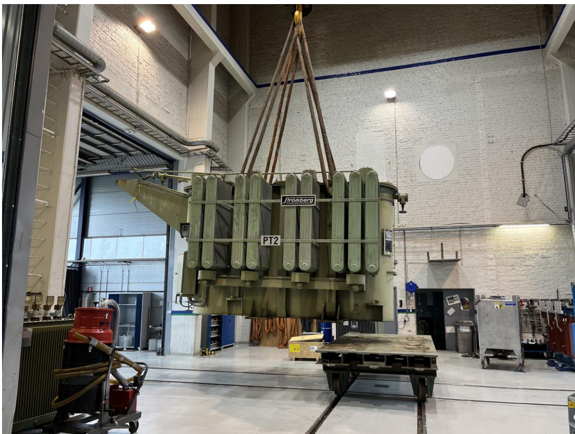
Kuva 7. Muuntajan nosto kiskokärryille
