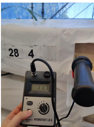
Kuva 7: Kosteusmittaus työmaalle saapuneesta elementtikuormasta
