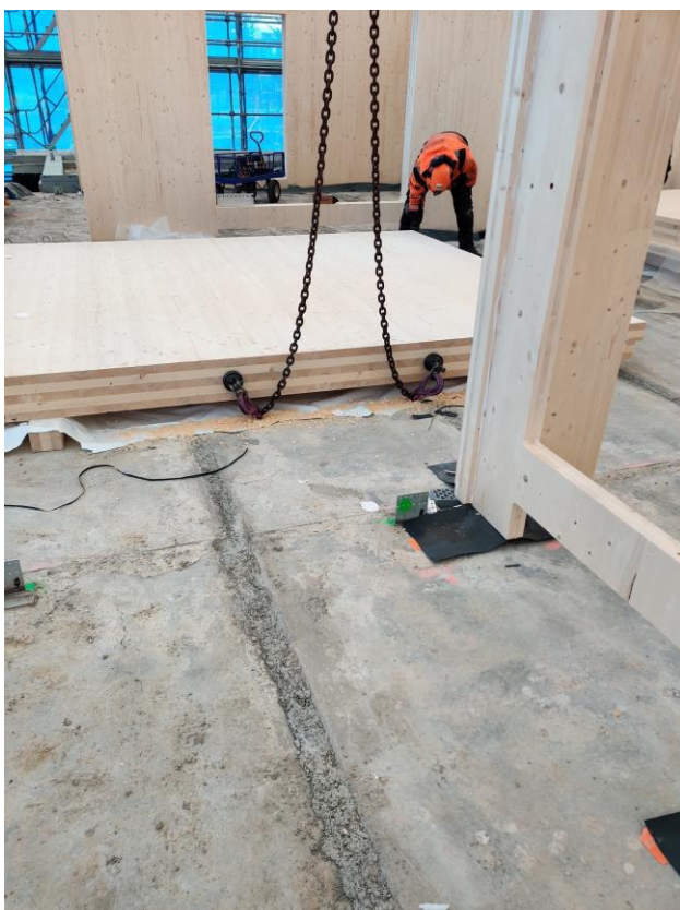
Kuva 5: Elementin nostotyöt käynnissä
