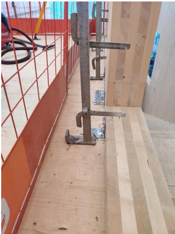
Kuva1: Viisilamellinen CLT-seinäelementti
