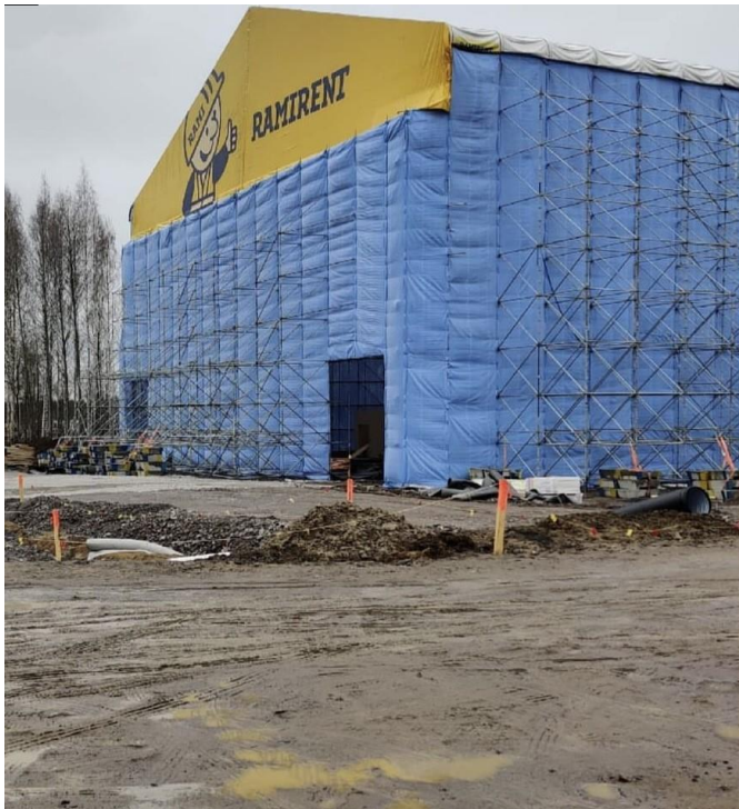
Kuva 8: Sääsuojateltan sisällä rakentuu CLT-päiväkoti
