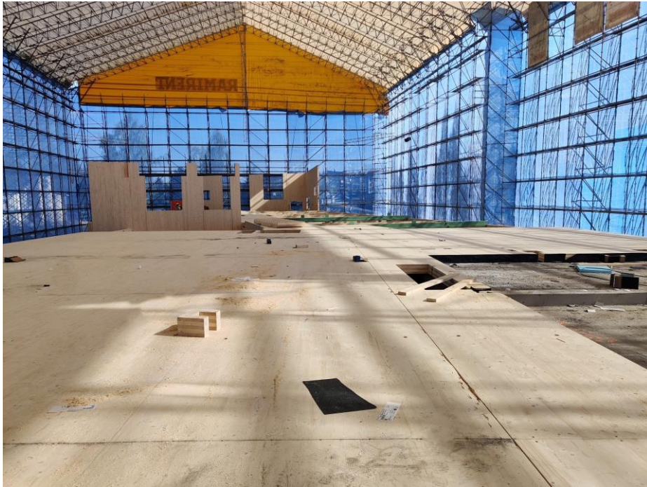
Kuva 9: Ensimmäisen kerroksen seinäelementit sekä välipohjakerros asennettuna
