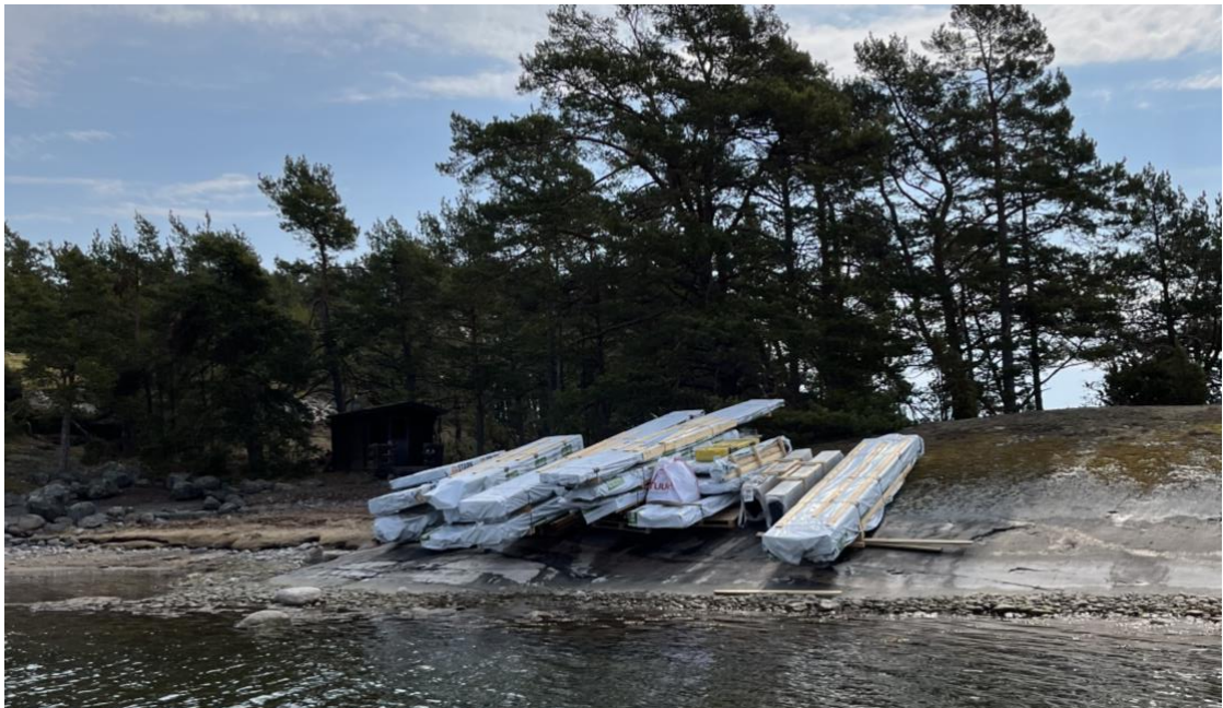
Kuva 7. Esimerkki virheellisestä varastoinnista. Liukas ja kalteva kallio hankaloittaa materiaalien haalausta.
