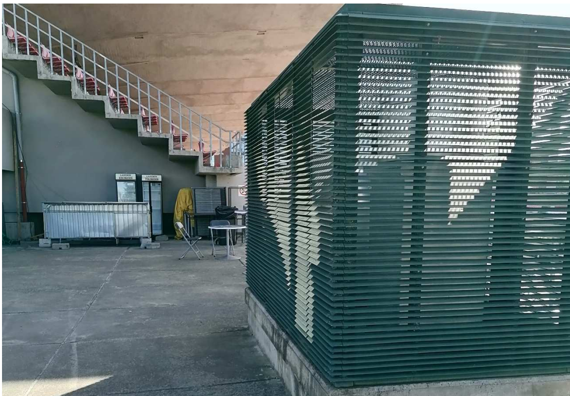
Kuva 70. A-katsomon molemmin puolin sijaitsee taloteknisten laitteiden suojarakenteita, jotka erottuvat selkeillä tummuuskontrasteilla ympäristöstään.
