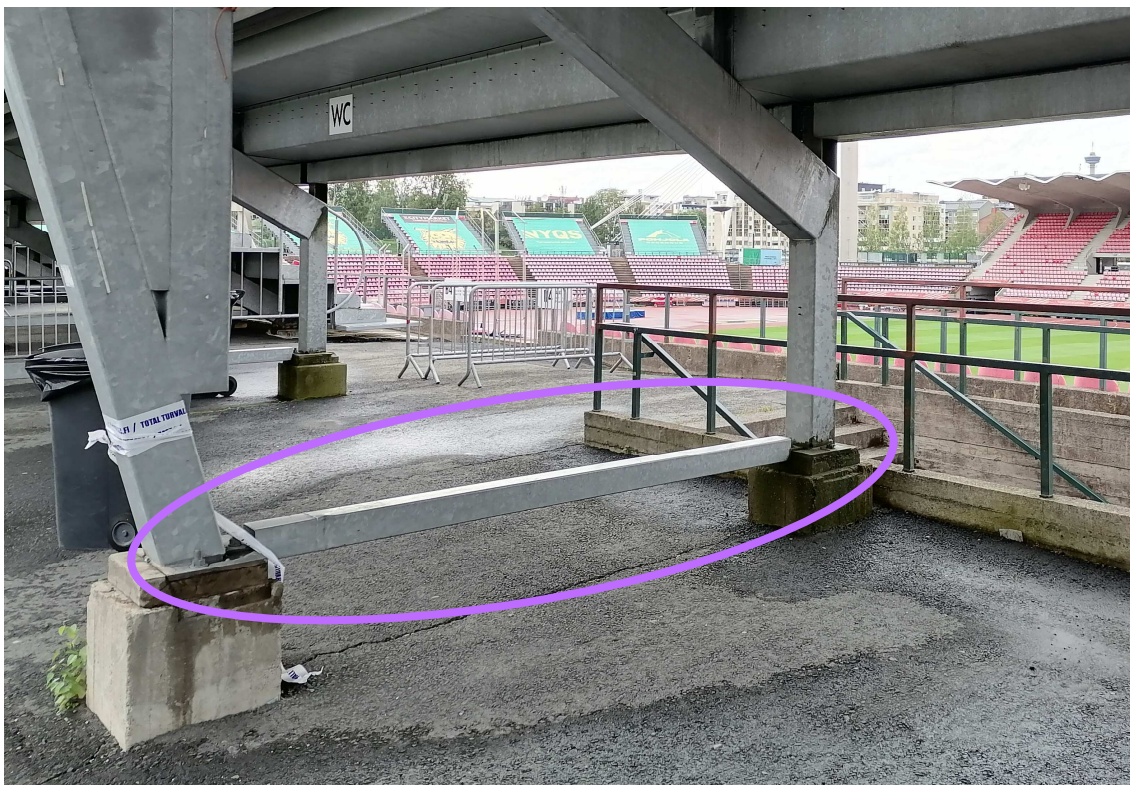
Kuva 83. Katsomon metallipilareita yhdistävät palkit luovat kompastumisriskin.
