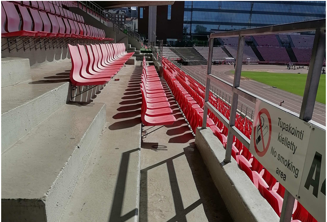
Kuva 35. Sisäänkäyntitasanteelta nousevien portaiden alaosassa avokaide on korotettu.
