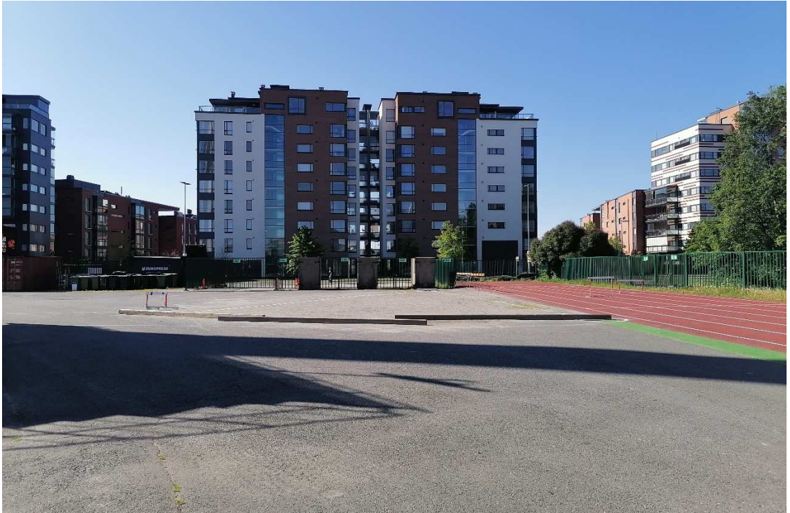
Kuva 75. Ratinan sillan kulma toimii huoltopihana, jossa hoidetaan logistiikka- ja huoltoliikenneyhteydet stadionin alueelle. Kuvassa oikealla on stadionin pituushypyn suorituspaikka.
