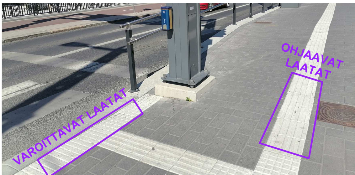
Kuva 21. Taktiiliopasteen varoitusalueella käytetään kolikkokuviointia, joka tuntuu jalan alla ja valkoisella kepillä sekä erottuu tummuuskontrastilla taustaltaan. Ohjaavien laattojen raidat helpottavat kulkusuunnan havaitsemista.
