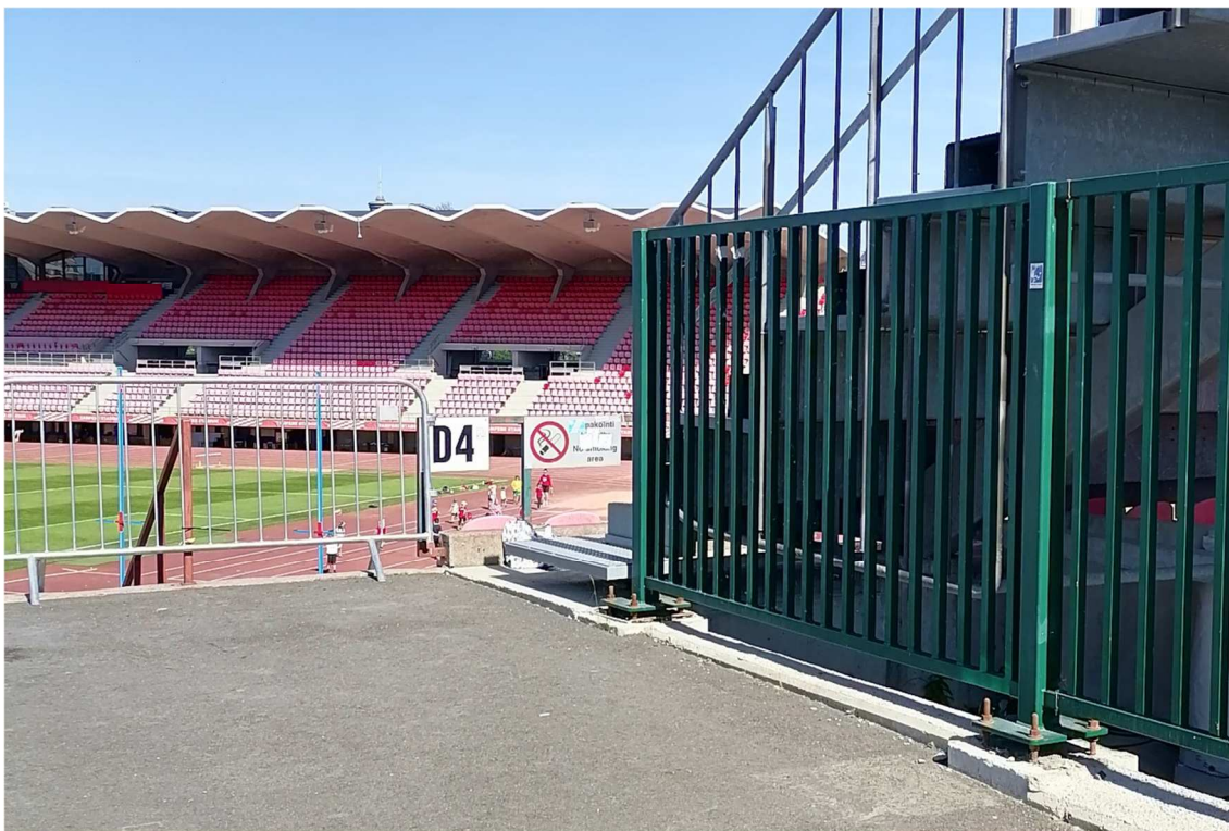
Kuva 107. Portaiden eteen tulee lisätä varoitusalueet ja niiden tummuuskont-rasteja tulee parantaa.
