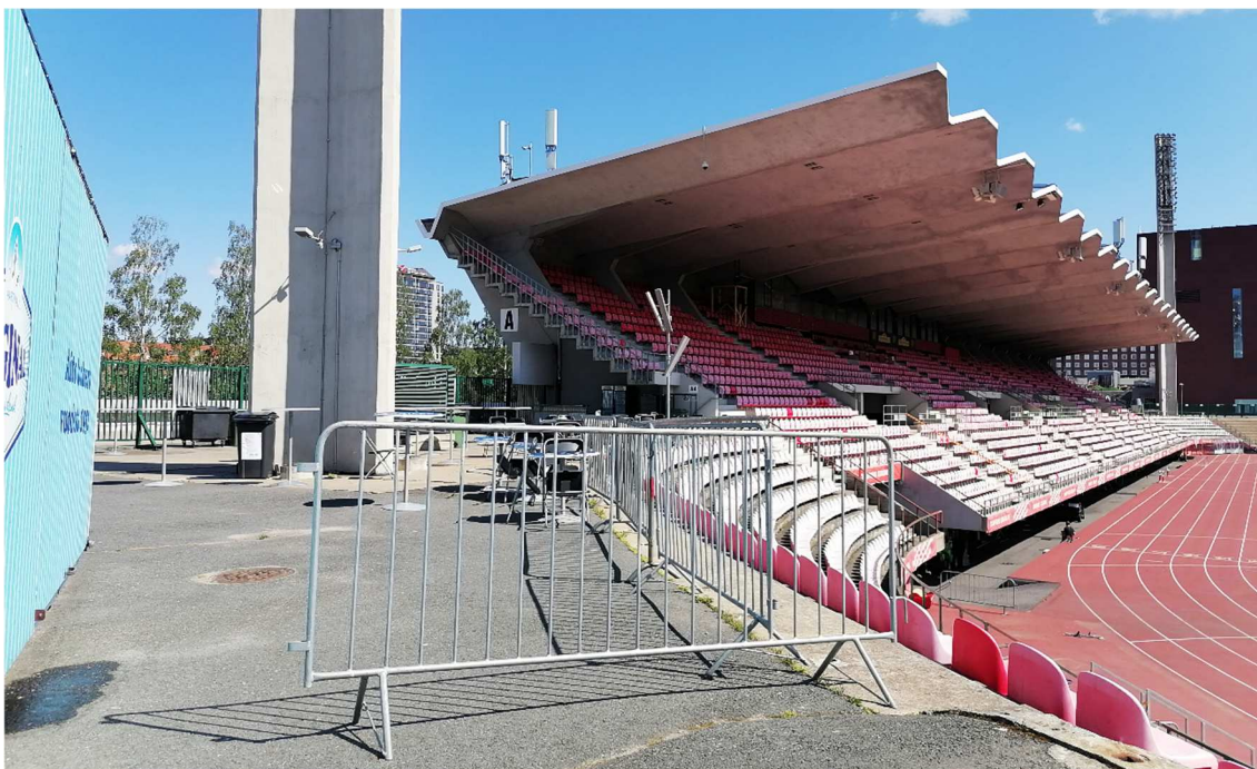
Kuva 68. C1-katsomossa käytetään siirreltäviä aitoja, joilla ei pystytä rajaamaan aluetta turvallisesti.
