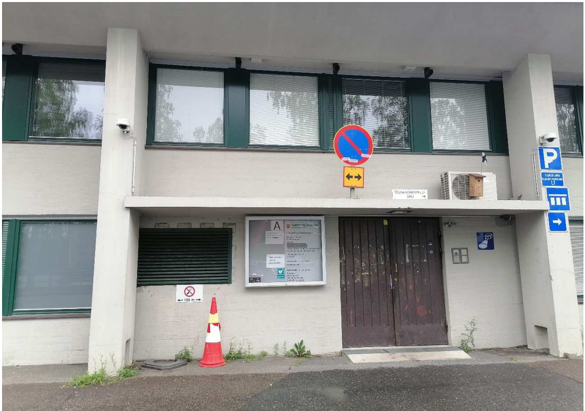
Kuva 54. Pääsisäänkäynti on vaatimaton ja vaikeasti havaittava.
