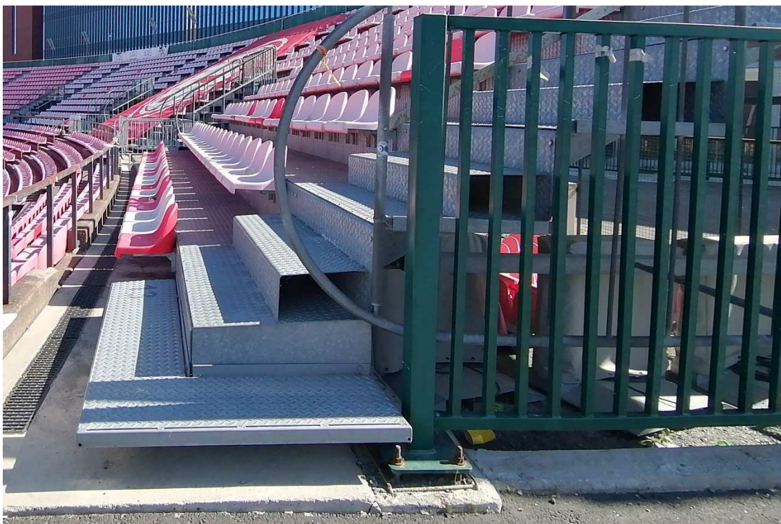
Kuva 109. Metalliportaiden alkamiskohtaa on vaikea havaita. Askelmien terävät kulmat, tummuuskontrastien sekä varoitusalueen puuttuminen ovat turvallisuusriskejä. Metallikatsomoissa on pyöreä käsijohte.
