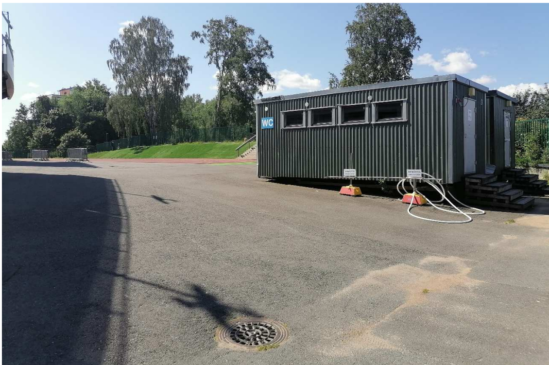
Kuva 67. WC-konttien vieressä on jyrkkä nousu Laukonsillan sisäänkäynniltä C-katsomolle. Konttien WC-tiloihin johtavista portaista puuttuvat kaiteet ja käsijohteet.
