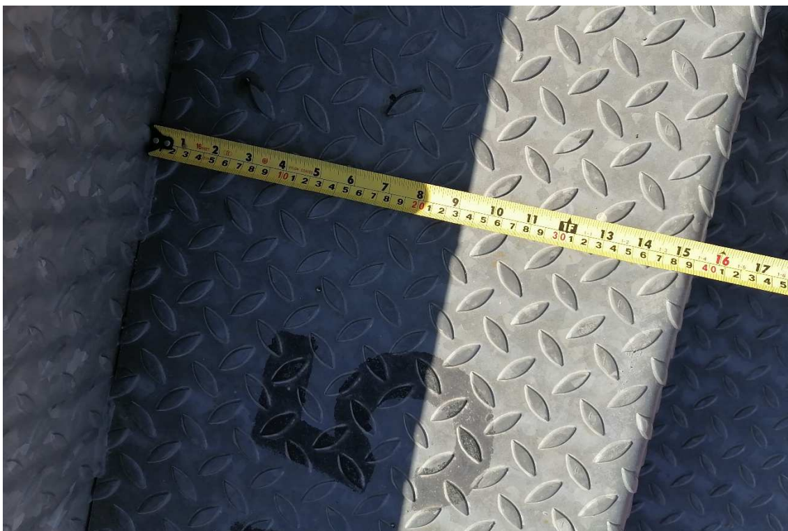
Kuva 108. Metallikatsomoiden porraskaskelmien etenemät vaihtelevat. Etureuna on pyöristetty ja rivinumerot haalistuneet.
