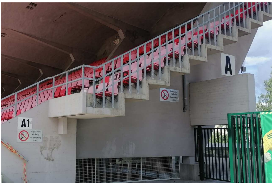
Kuva 34. Kuva korjausten jälkeen. Lisätyllä välijohteella katsomon reunapaikkojen turvallisuus parantui hieman. Kaiteeseen tulee lisätä suojaosa. Kai-teessa ei saa olla jalansijaa tarjoavia vaakasuoria rakenteita tai kuvioita, jotka mahdollistavat kiipeilyn.
