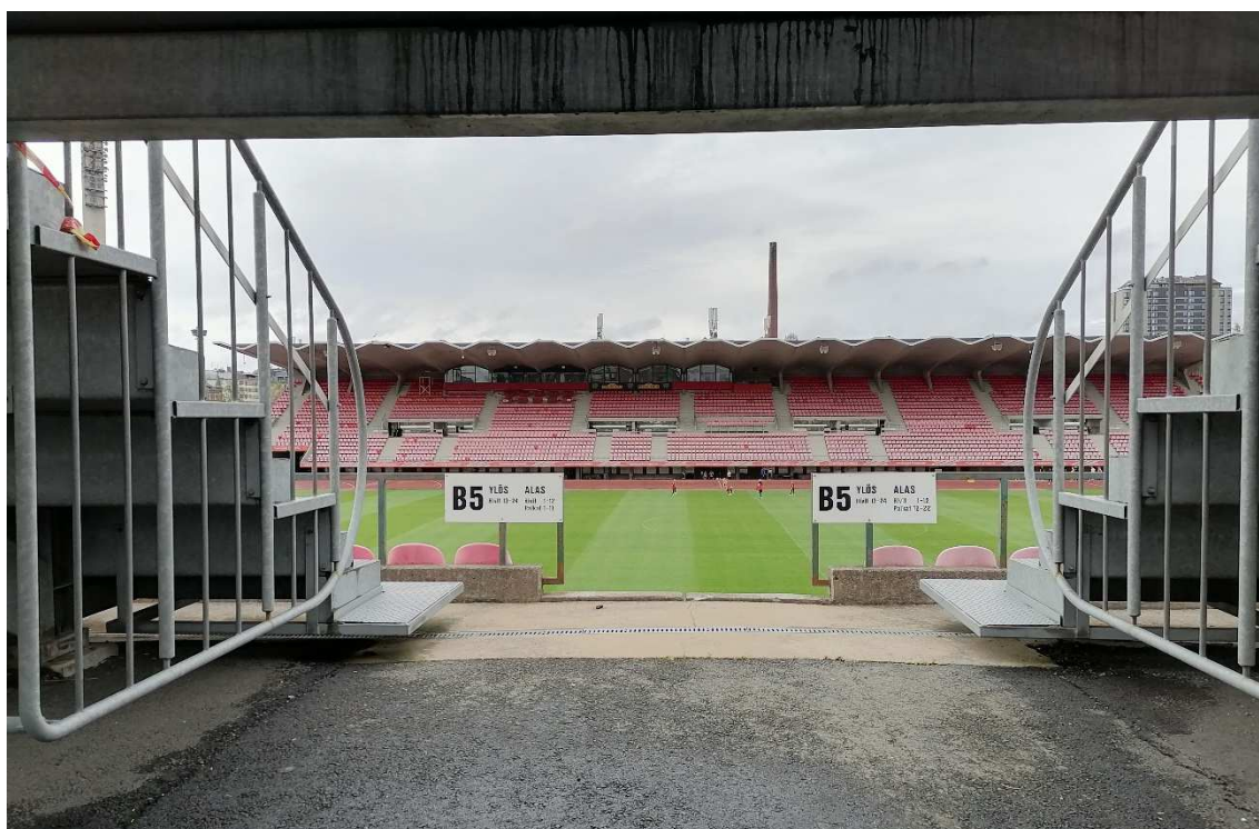
Kuva 85. Kulkuväylän vapaa korkeus on vain 2030 mm, minimikorkeuden ollessa 2200 mm.
