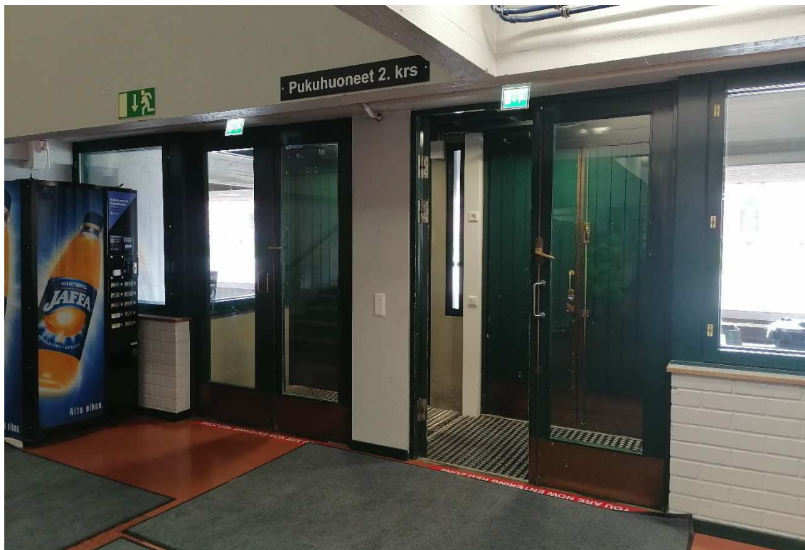
Kuva 59. Tuulikaapin ovet ja urheilukentän puoleinen uloskäynti erottuvat tummuudeltaan hyvin vaaleasta aulatilasta. Käyttöovi on liian kapea.
