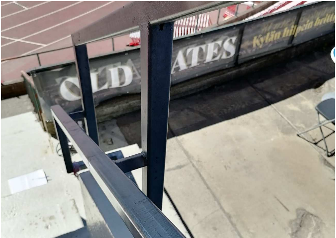
Kuva 32. Nelikulmaisesta käsijohteesta ei saa tukevaa otetta. Käsijohteen tulee olla pyöreää muodoltaan.
