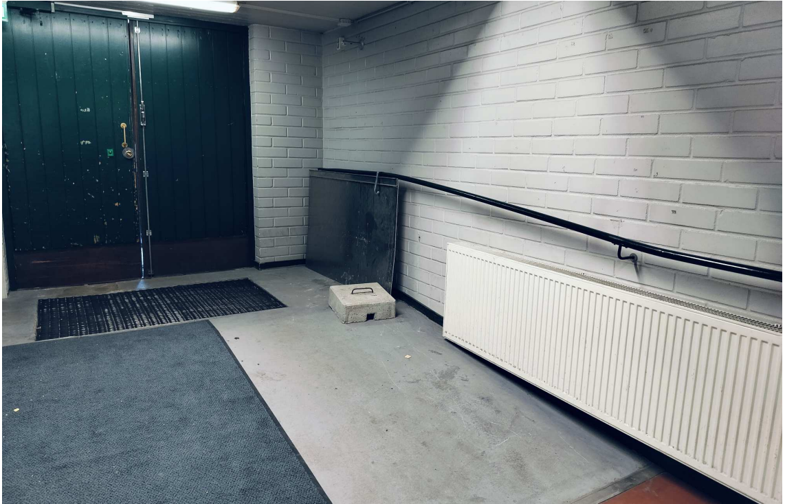
Kuva 56. Tuulikaapissa on käsijohde, mutta sen vieressä ei ole vapaata tilaa.
