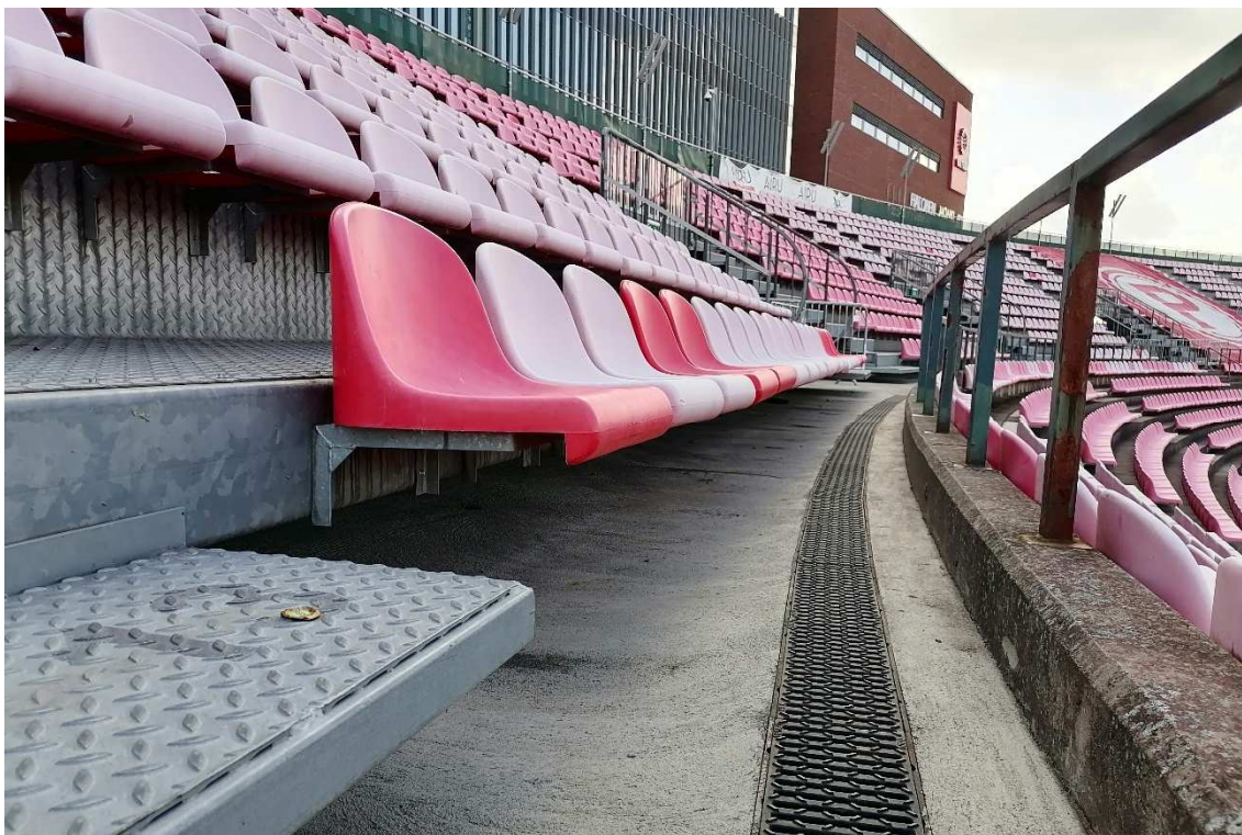
Kuva 110. D-katsomon ala- ja yläkatsomoiden välissä on avokaide.
