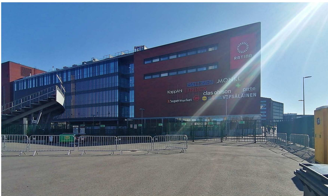
Kuva 93. Sisäänkäyntialue on avoin ja vapaa taloteknisistä rakennelmista.
