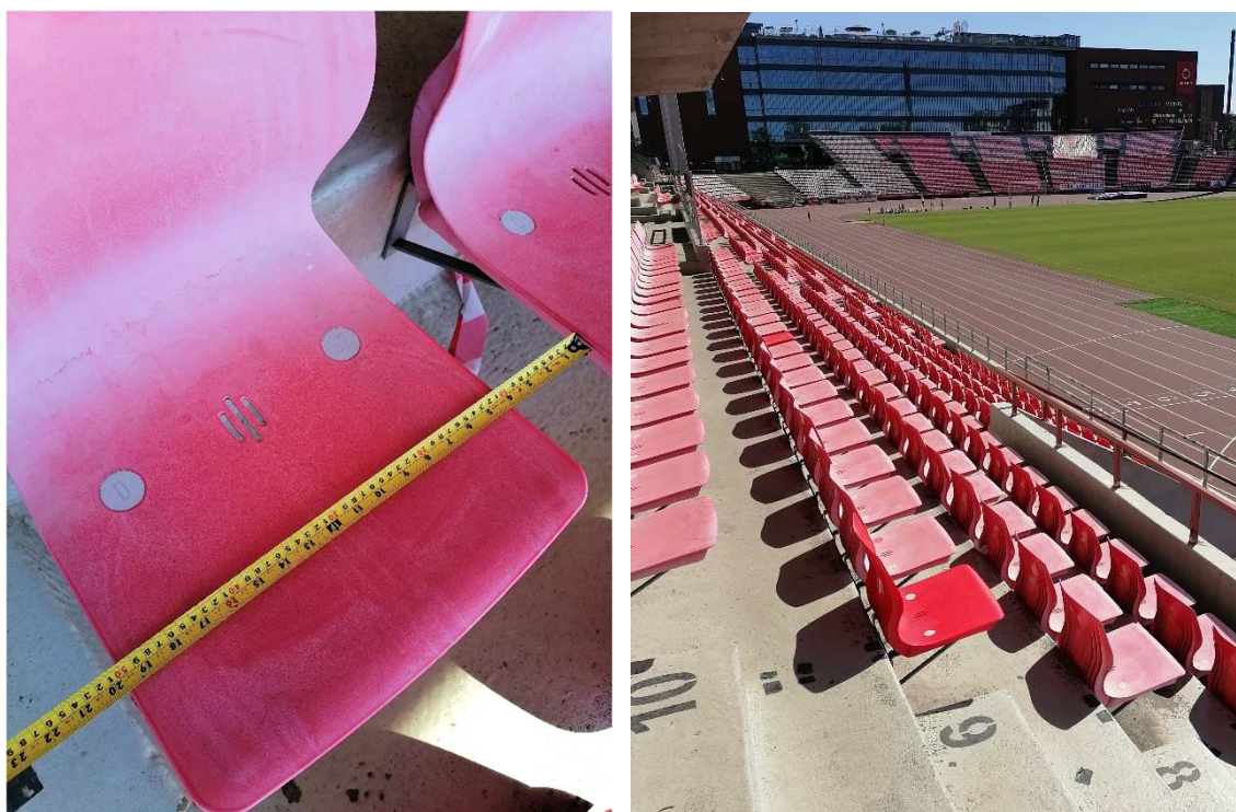
Kuva 42. Sivuttaista istuintilaa on 500 mm, jalkatilaa rajallisesti 400 mm.
