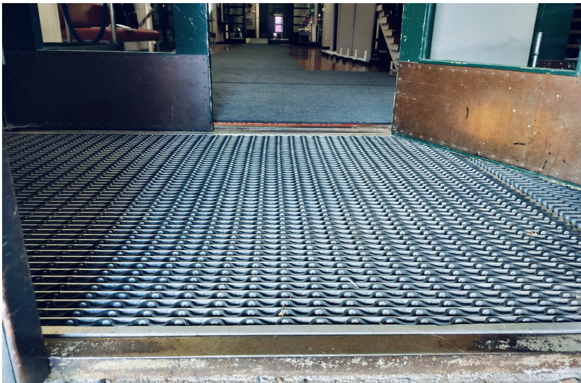
Kuva 60. Näkymä kentältä kohti Ratinan Rantatien pääovia. Ulko-ovien kynnyks on suorareunainen ja korkea, joten kulku apuvälineen kanssa on hyvin vaikeaa.
