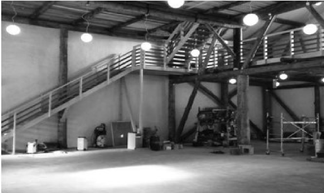
Kuva 18. Hallin suurseinät ovat savirapattu (Saviyhdistys, 2010)
