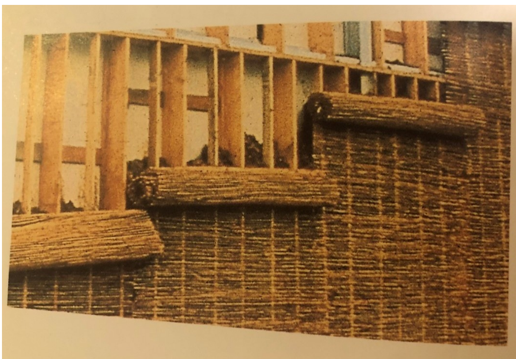
Kuva 1. Ruokomaton käyttö savi-puumassaeristuksen kanssa (Westermarck, Heuru & Bengt, Luonnonmukaiset rakennusaineet, 1998, s. 34)
