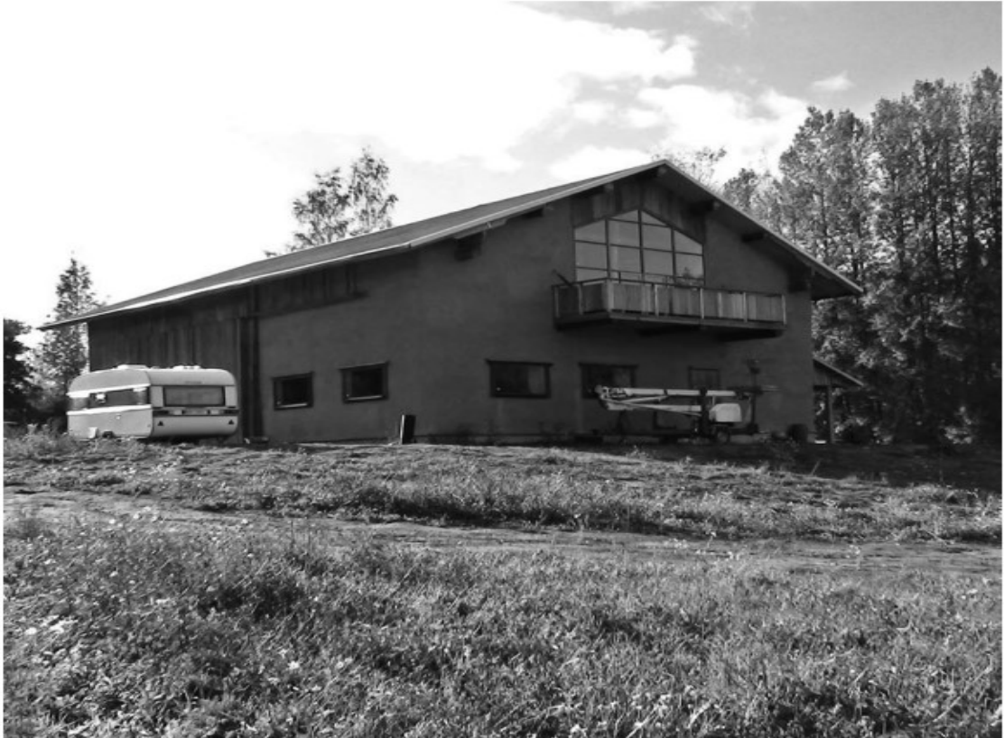
Kuva 17. Hallirakennus rakennettu pääosin savesta, oljesta ja puusta (Saviyhdistys, 2010)
