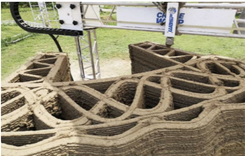
Kuva 13. Savirakennuksen tulostus 3DWASP:in nostritulostimella (Westermarck & Vinha, Esiselvitys luonnonmukaisista rakennustuotteista ja niiden käyttöpoteentialista, Nature CO2-hanke, 2023, s. 62)
