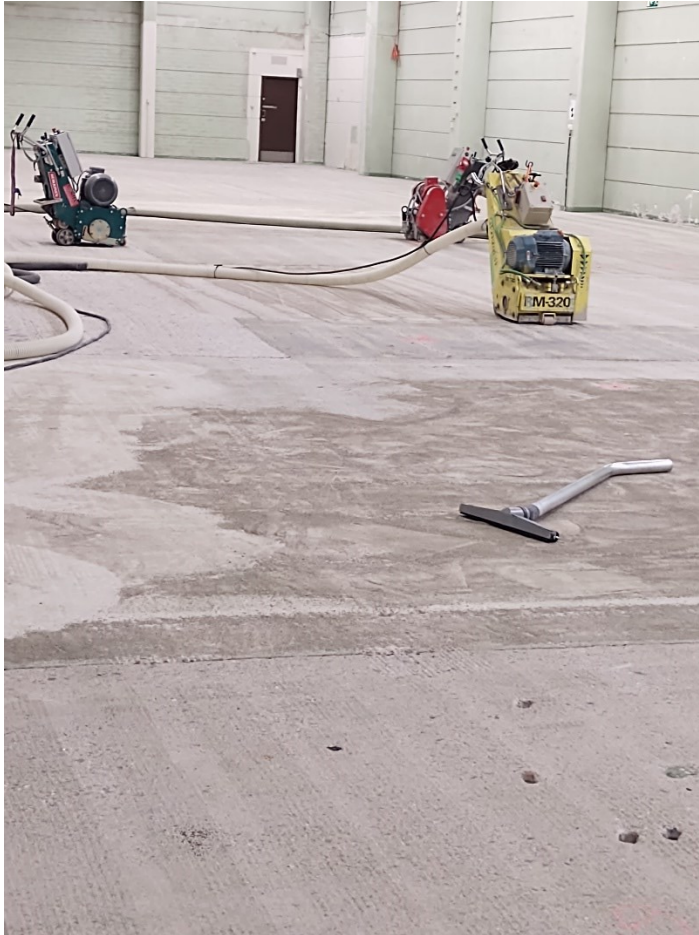
Kuva 15 Lattialle tehty tartuntapinta jyrsimällä.
