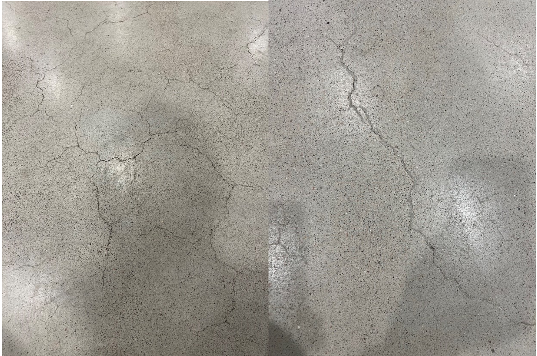
Kuva 18. Halkeillutta lattiaa
