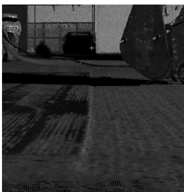
Kuva 7. Pistepilvessä näkyvä lattian jyrinnästä syntynyt pykälä. Kuvassa on siivoamaton yksi pistepilvi, jossa on noin 10 miljoonaa pistettä noin 2 mm pistetiheydellä.
