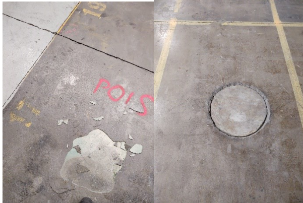
Kuva 13. Lohkeileva pinnoite sekä kaivo
