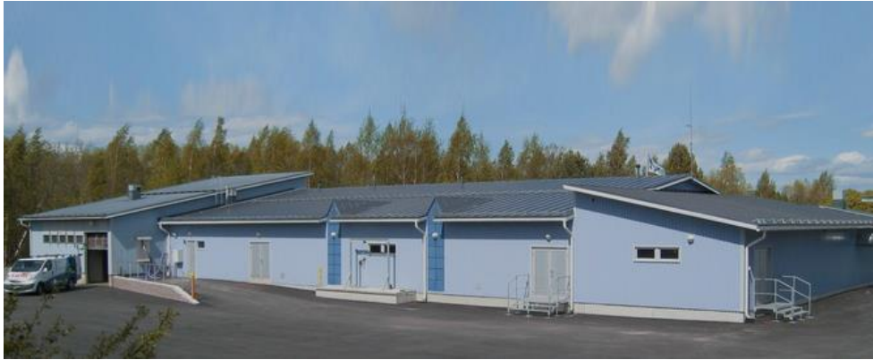
Kuva 23. Näkymä 4 Kiteen vesi- ja viemärintilaitokselle
