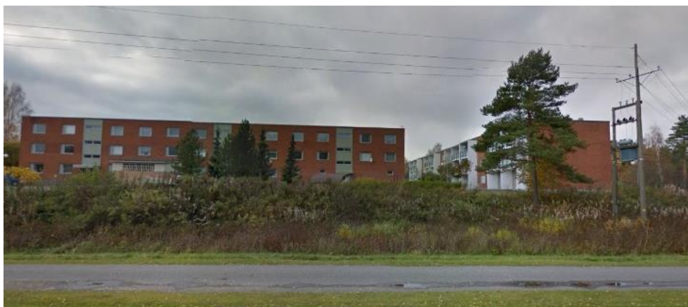
Kuva 25. Näkymä 6 kerrostalojen alueelle.
