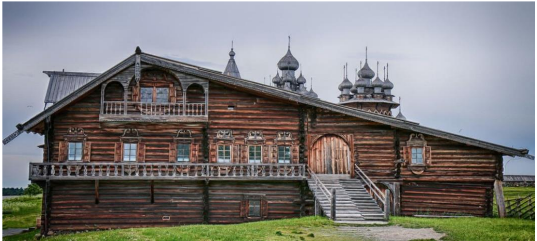
Kuva 9. Vauras talonpojan Oshevnevin talo, kuljetettu museoon Kizhi kylästä Oshenevo. Usein karjalaisissa taloissa on epäsymmetrinen harjakatto. Kuva: Karelia WIKI.
