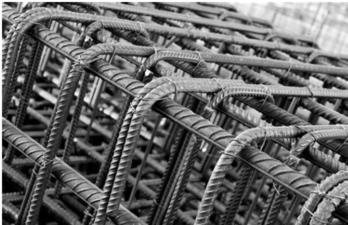
Kuva 8 Raudoitteiden valinta ja häkin rakentaminen [19]
