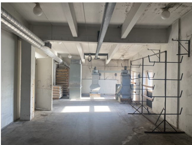
KUVA 21. Kemikaalivaraston katon palkki-pilarirakenne. Ulkoseinien yläosaa kiertää palkki (Jori Leppinen 2023).
