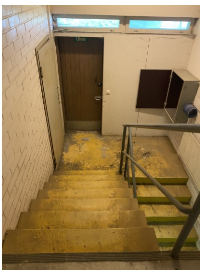
KUVA 34. Välitasanteelle avautuva sisäänkäynti (Jori Leppinen 2023).
