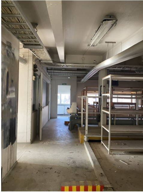
KUVA 38. Vesialtaiden päälle on rakennettu puuvälipohja ja hyllyjä. Huoltokäytävän korkoeroa suhteessa lattiaan ei ilmennyt rakennuslupakuvista (Jori Leppinen 2023).
