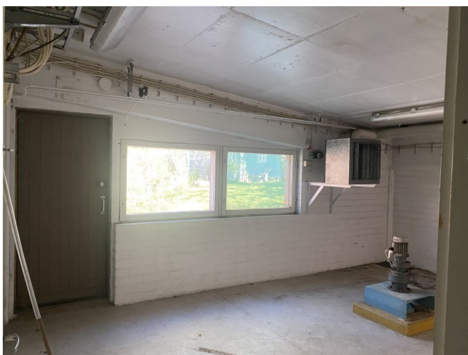
KUVA 35. Vuonna 1977 rakennetun laajennusosan kerroskorkeus on matalimmillaan alle kaksi metriä. Kuva teknisestä tilasta (Jori Leppinen 2023).
