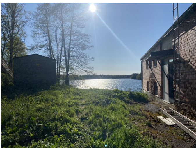
KUVA 27. Näkymä eteläpuolelta länteen kohti Littoistenjärveä. Kuvassa vasemmalla pieni muuntamorakennus (Jori Leppinen 2023).
