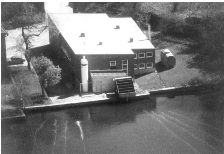
KUVA 17. Littoisten vesilaitos laajennusten jälkeen vuonna 1988. (Littoisten säännöstely-yhtiö 20 vuotta 1988, 51.)
