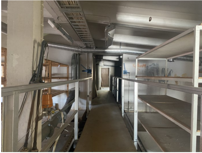
KUVA 36. Näkymä toisessa kerroksessa altaiden huoltokäytävälle (Jori Leppinen 2023).
