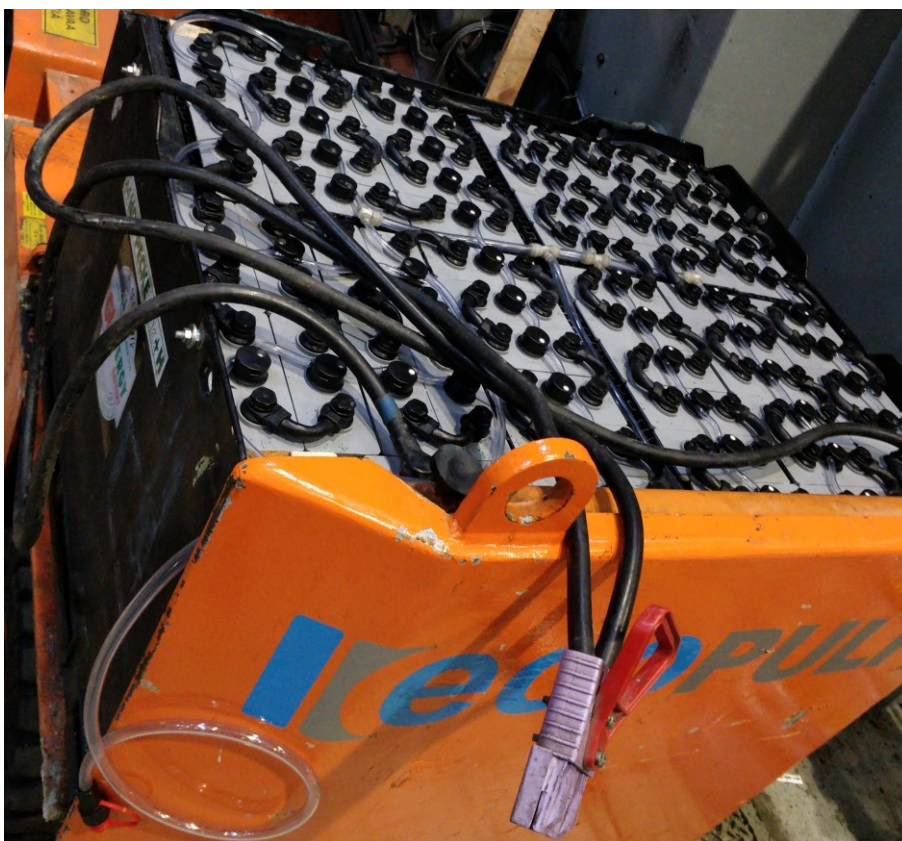
Kuva 7. Uudet akkukennot kytkettyinä ja vesitysletkut asennettuna.
