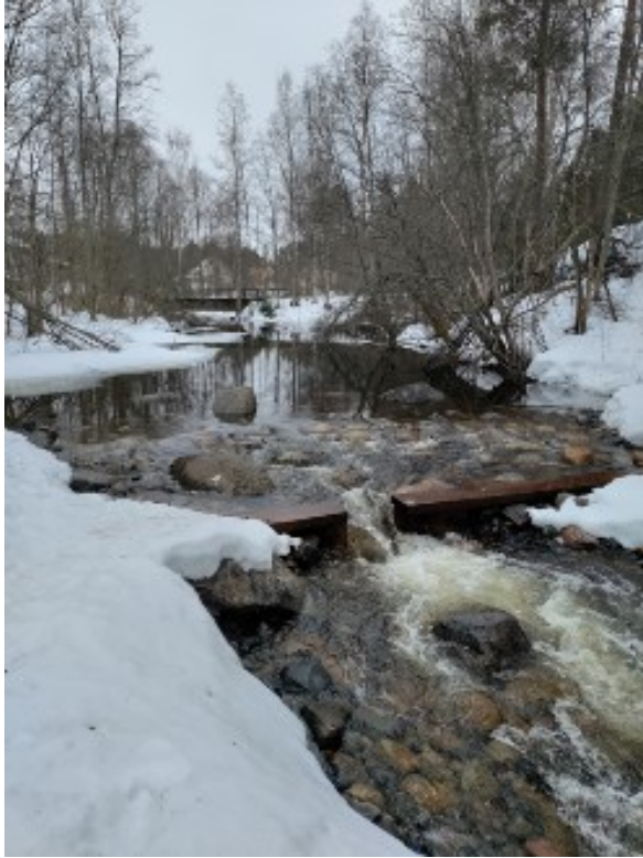
Kuva 5. Pohjapato, jonka keskikohtaan on leikattu aukko ja vesi virtaa padon kohdalta va- paammin (Kuva Panu Immonen)
