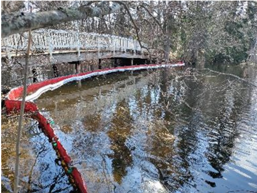
Kuva 23. Öljypuomia levitettyä Urpolanlammen luusuassa. Puomi oli paikoillaan muutaman viikon. Vaikutusta puomilla on tuskin ollut, kuin vain pintavirtauksiin puomin lähistöllä alavirtaan päin. (Kuva Panu Immonen)
