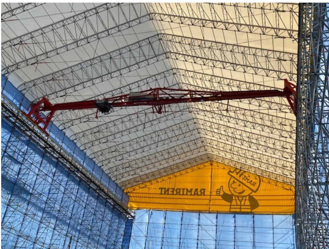
KUVA 2. Vapaasti seisova sääsuoja siltanosturilla kuvattuna sisältäpäin (Ramirent 2021).
