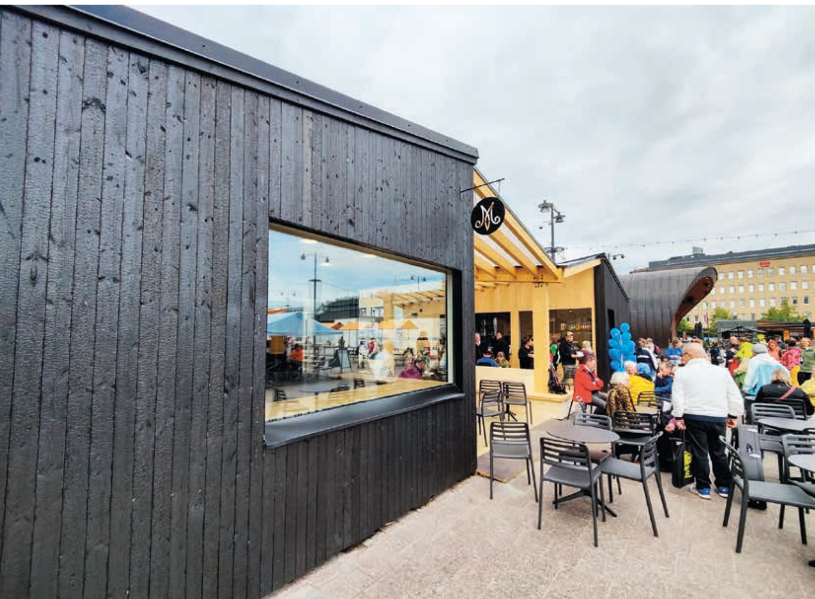
Joensuun torin Marttakahvion ulkoseinä on hiillettyä puuta Kuva: Joona Kotilainen
