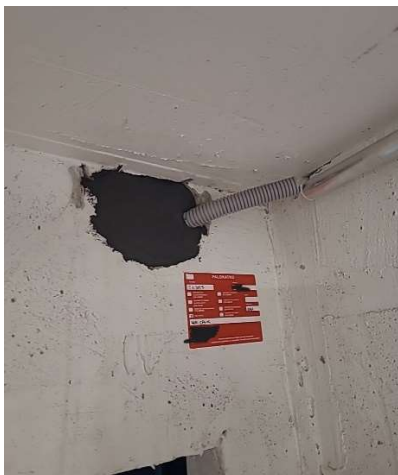
Kuva 2. Palokatko toteutettu grafiittipohjaisella palokatkomassalla. Valokuva Pasilassa sijaitsevalta asuinrakennustyömaalta.
