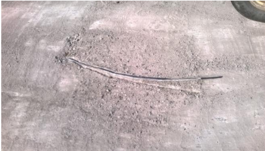
KUVA 18: Ruosteeton teräs mastiksimassan poiston jälkeen
