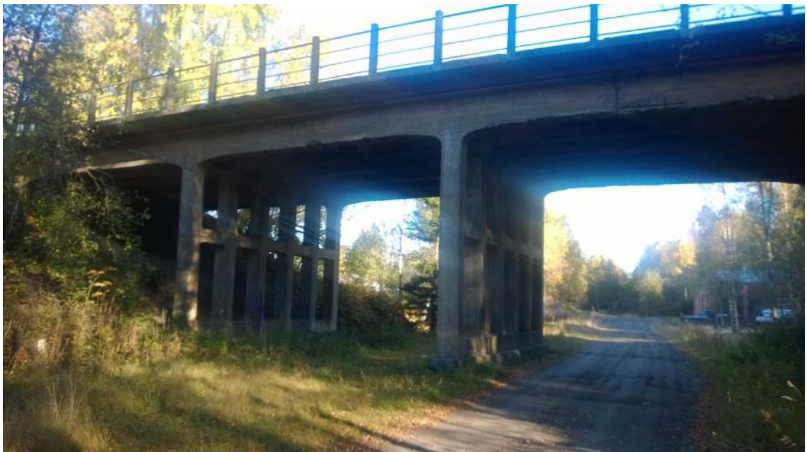
KUVA 7: Ratapihasilta kuvattuna alhaalta
