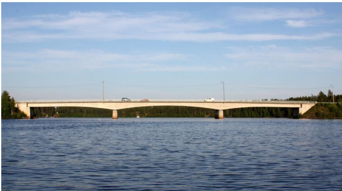
KUVA 4. Kiiminkijoen teräsbetoninen kotelopalkkisilta, rakennettu vuonna 1954.
