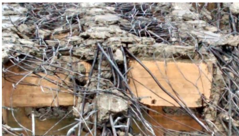
KUVA 17: Purettua sillan kansirakennetta, pilarilinja
