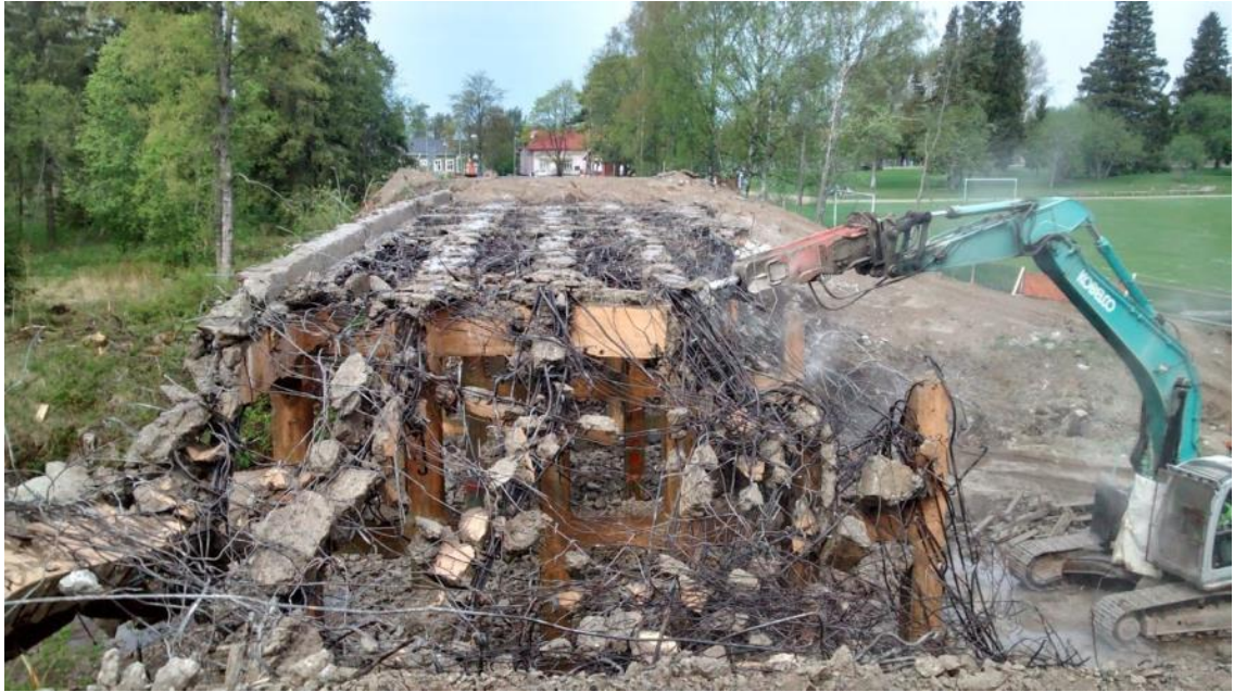
KUVA 41: Sillan kansirakenteen rammerointia
