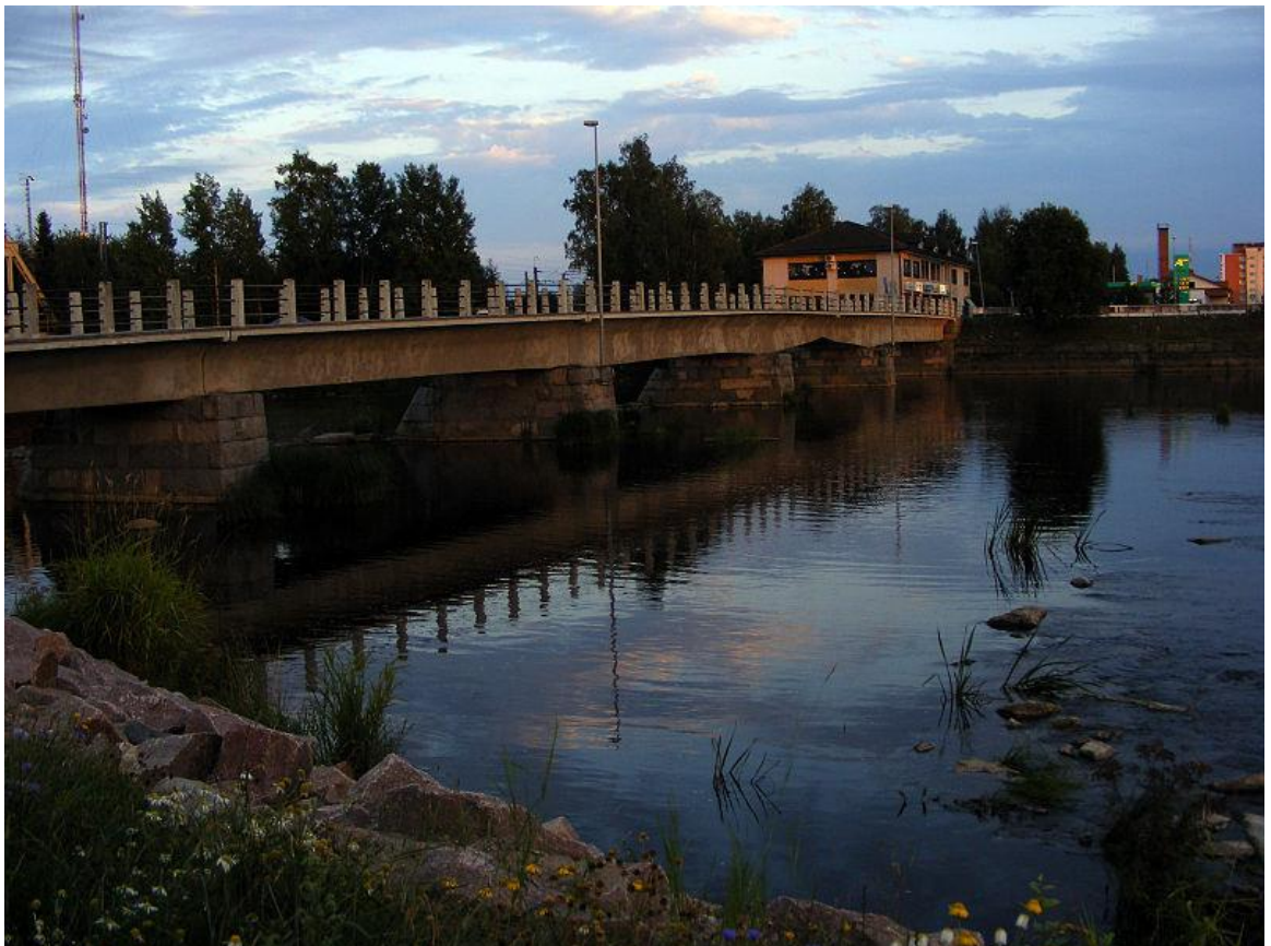
KUVA 3. Teräsbetoninen ulokepalkkisilta Ylivieskassa, valmistunut vuonna 1912.
