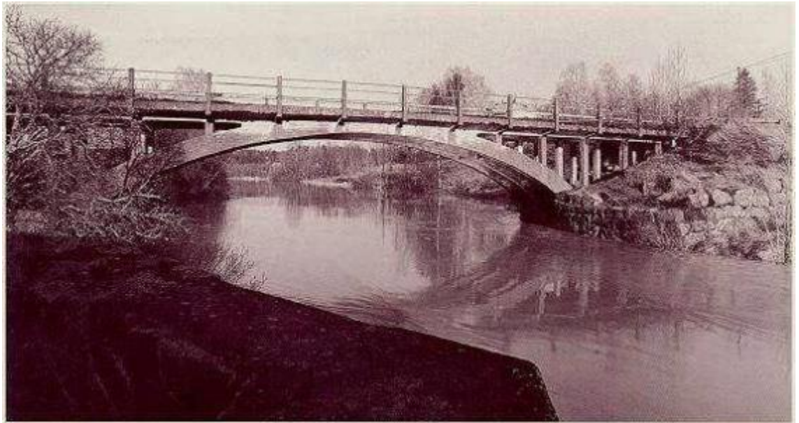
KUVA 2. Tönnön museosilta vuodelta 1911 Orimattilassa. Suomen ensimmäinen teräs-betoninen kaarisilta sekä vanhin säilynyt teräsbetonisilta Suomessa.
