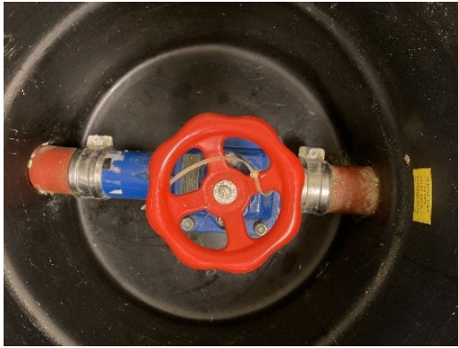
Kuva 1. Viemärsulkuventtiili DN70. (Kuva: Mikko Pesonen)
