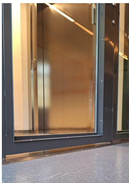
Kuva 7. Kynnyksetön palo-ovi, jossa pieni rako oven ja lattian välissä sekä palamaton materiaali 100 mm oven molemmin puolin (Kuva: Outi Savijärvi 2023).
