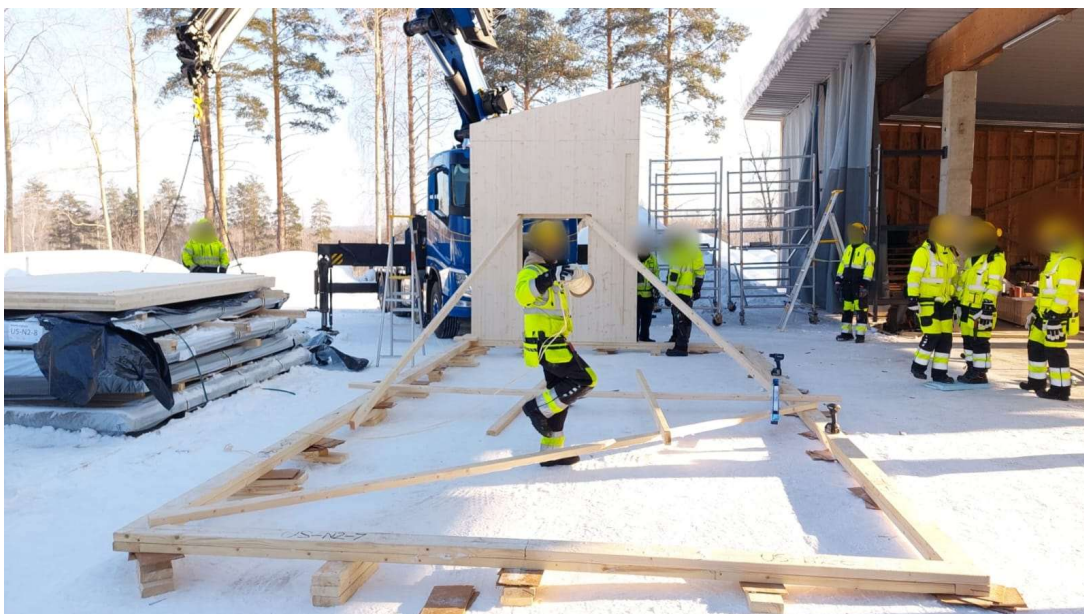
Kuva 34. Rakennuksen pohjakehikko (Kuva: Jouni Holopainen, 2023).
