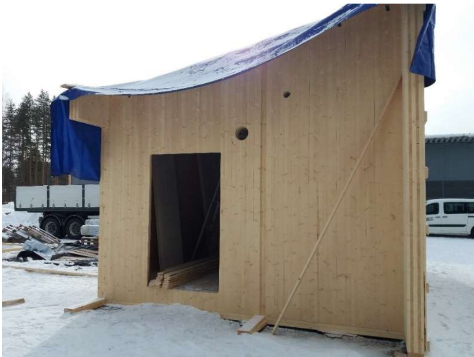
Kuva 36. Sääsuojaus (Kuva: Annikki Tanskanen, 2023).
