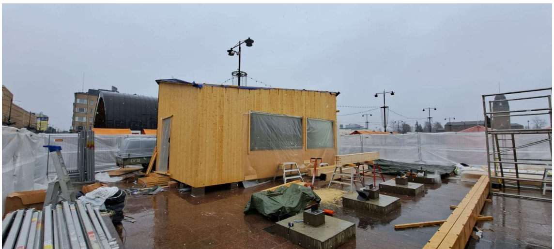
Kuva 40. Rajallinen rakennusalue (Kuva: Jouni Holopainen, 2023).
