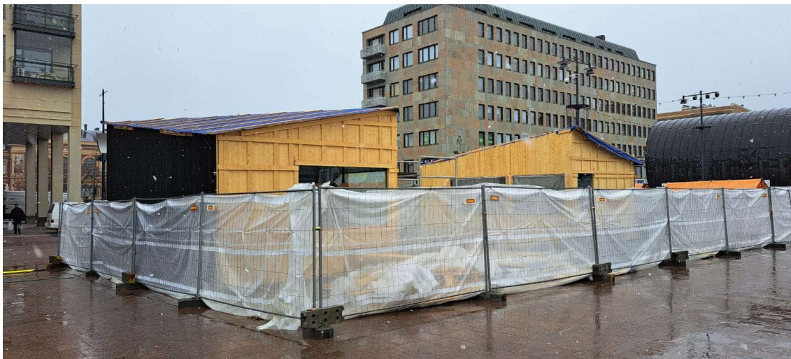
Kuva 41. Torin työmaan raja-aita (Kuva: Jouni Holopainen, 2023).
