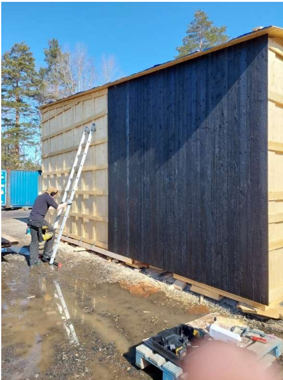
Kuva 33. Ulkoverhous (Kuva: Miika Räätäri, 2023).
