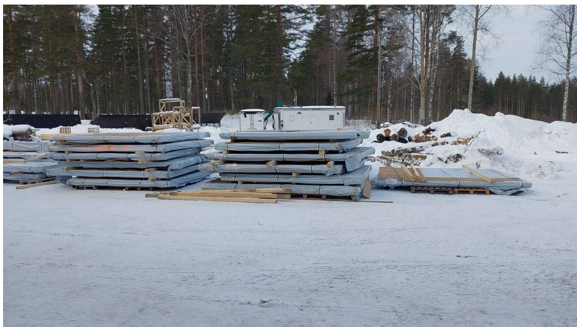
Kuva 42. CLT-elementtien säilyttäminen (Kuva: Miika Räätäri, 2023).
