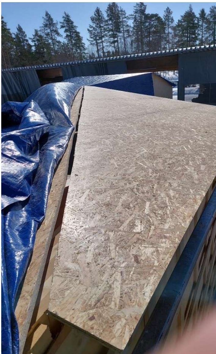
Kuva 30. Yläpohja (Kuva: Miika Räätäri, 2023).
