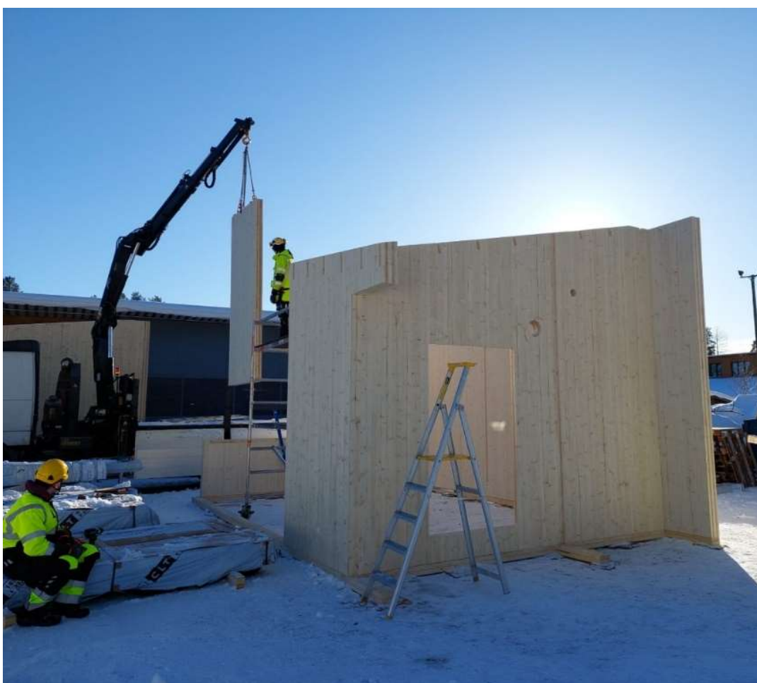
Kuva 35. Elementtien asennus (Kuva: Miika Räätäri, 2023).
