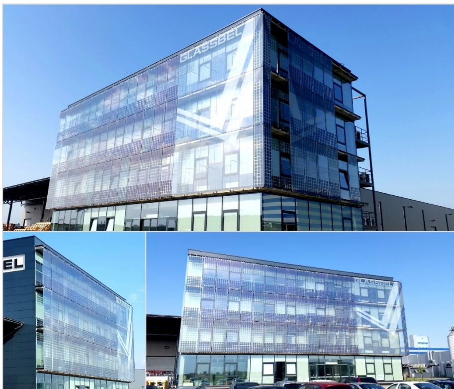
Kuva 18. Julkisivuihin integroitu PV-järjestelmä, Klaipėda, Liettua [34].
