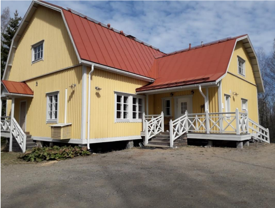
Kuva 7. Pääsinniemen kylätalo (Kuva: Kati Askola)
