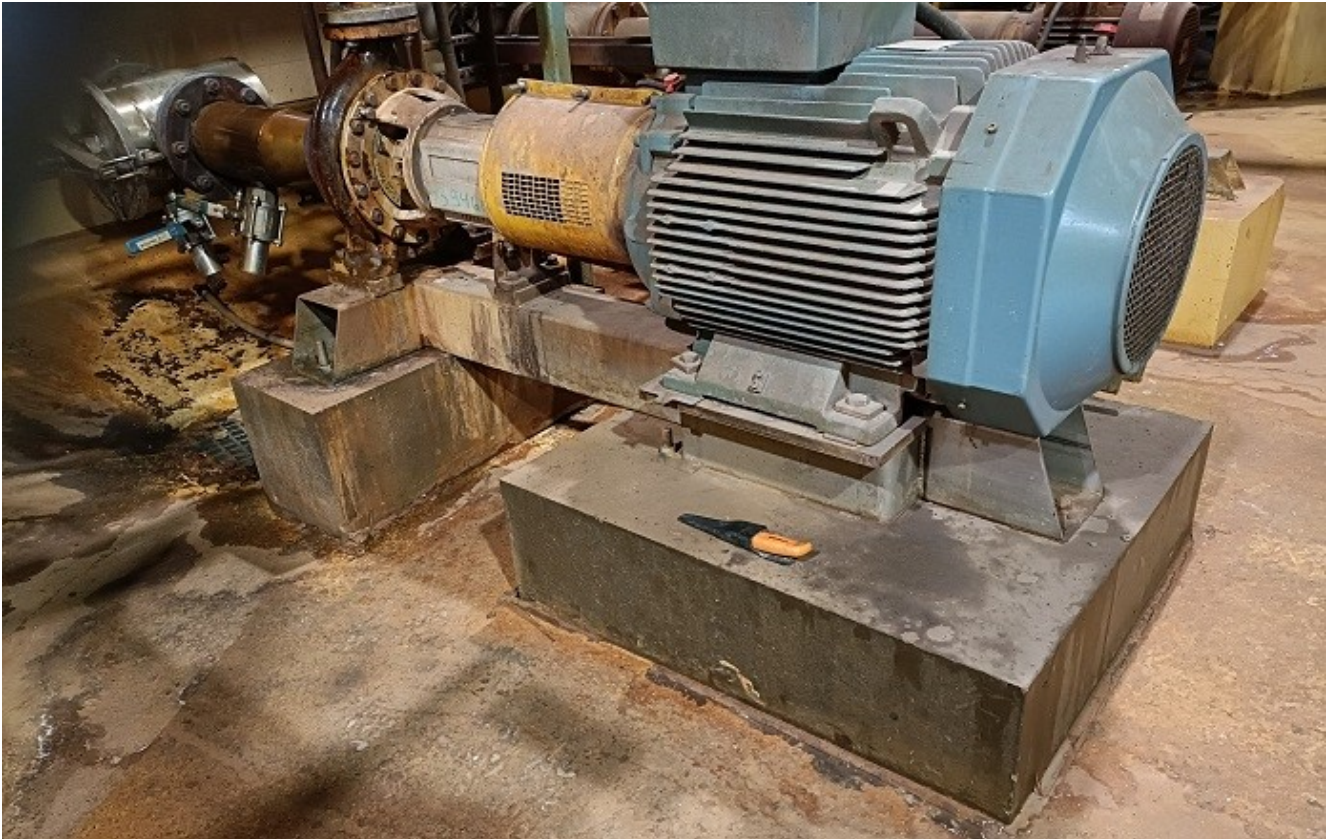
Kuva 1. Epoksibetonista valettu koneperustus
