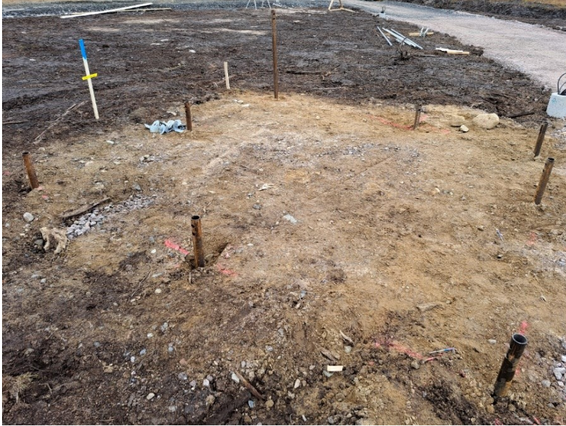
Kuvio 18. Tupakkakatoksen ruuvipaalut upotettuina
