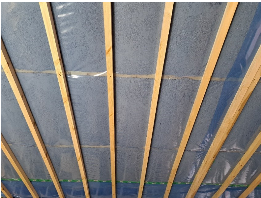
Kuvio 35. Puhallusvillat laitettuna yläpohjan päälle
