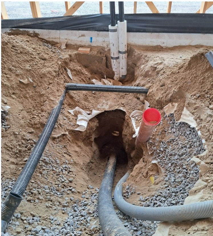
Kuvio 6. Esille kaivetut putket teknisessä tilassa
