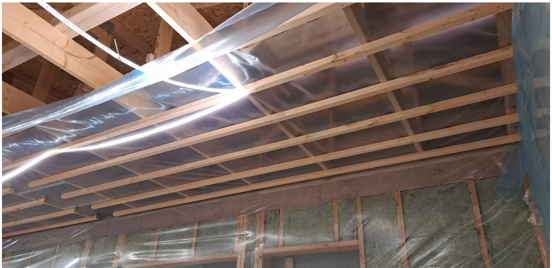
Kuvio 14. Höyrynsulkumuovi ja koolausta yläpohjassa
