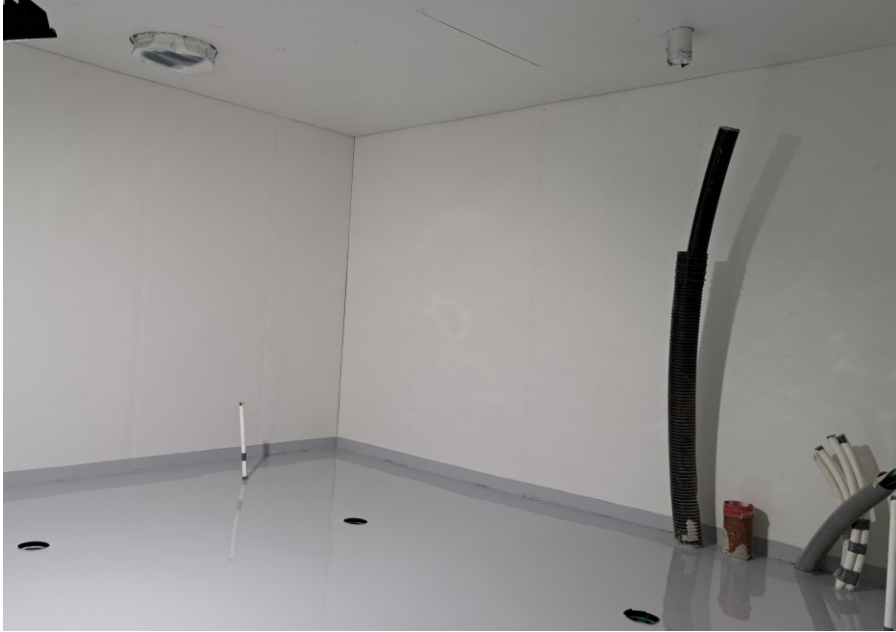
Kuvio 25. Teknisen tilan lattia pinnoitettu ja muut pinnat pohjamaalattu
