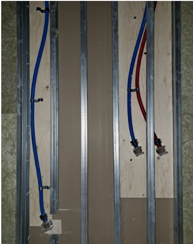
Kuvio 31. Käyttövesiputket asennettuina
