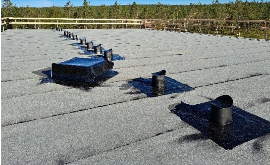
Kuvio 3. Pohjakermi asennettu ja läpivientien tiivistykset tehty
