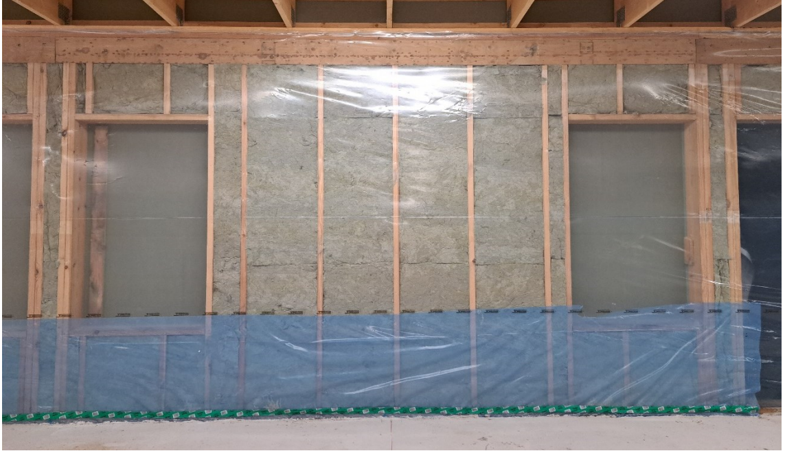
Kuvio 10. Höyrynsulkumuovi asennettuna ulkoseinään
