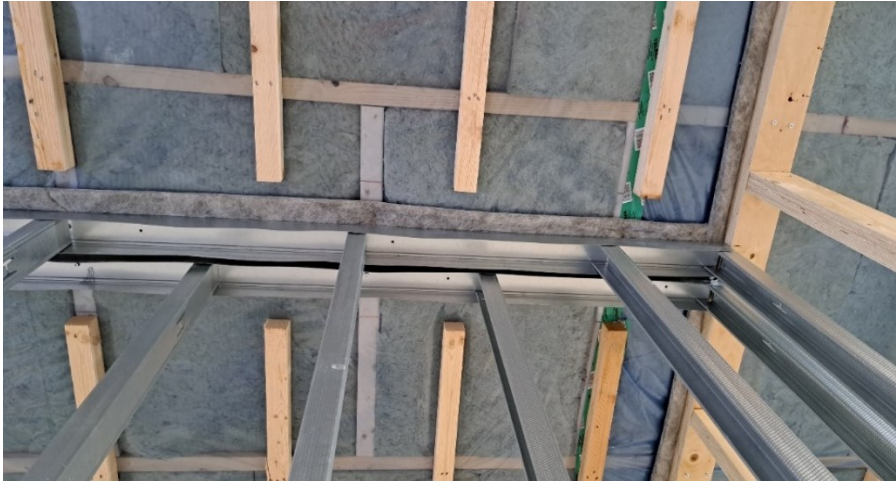
Kuvio 23. Huoneistojen välinen väliseinärunko
