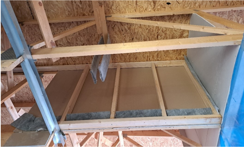
Kuvio 27. Vesikattoon ylettyvän palo-osastoivan seinän teko
