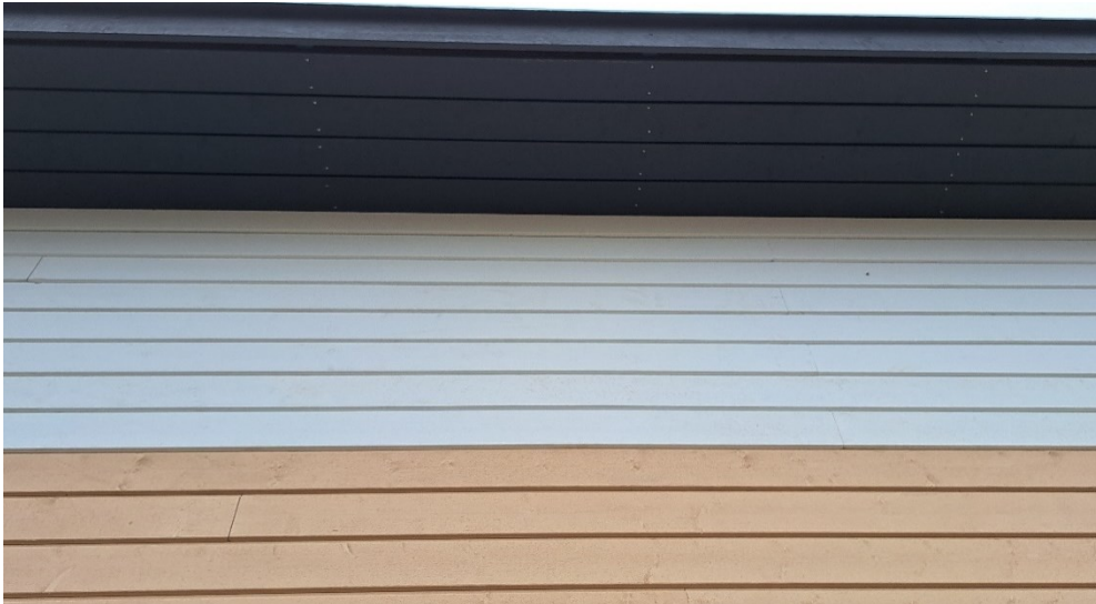
Kuvio 26. Julkisivun valmista panelointia ja laudoitusta
