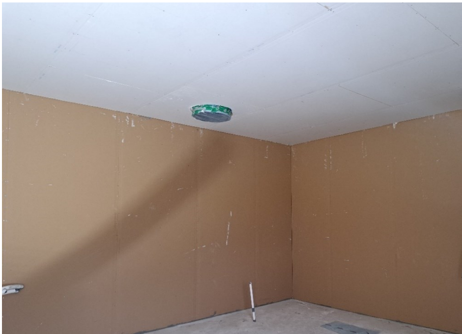
Kuvio 22. Kipsilevyt yläpohjassa
