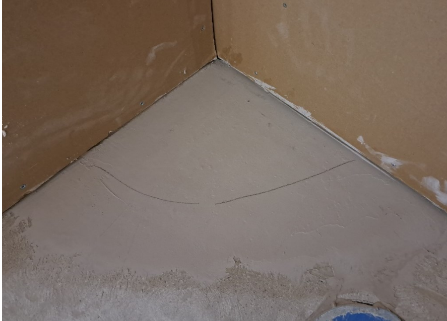
Kuvio 36. Märkätilan lattian kaatojen korjausta
