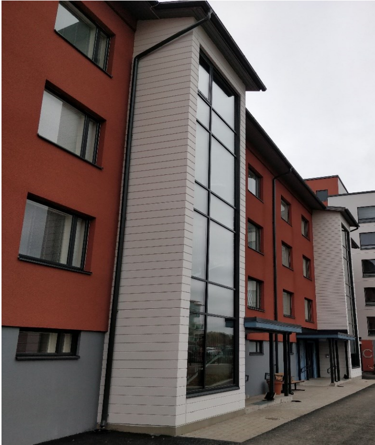
Kuva 2 Jälkiasennetun hissin aiheuttama julkisivumuutos.
