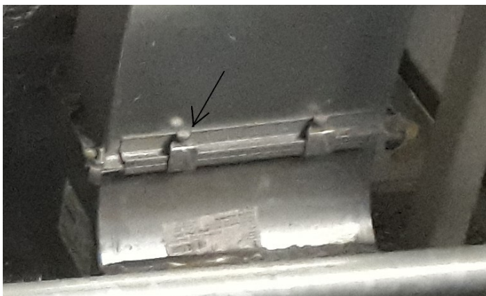
Kuva 3: Nuoli osoittaa ruuvattavaan kynsiliittimeen.
