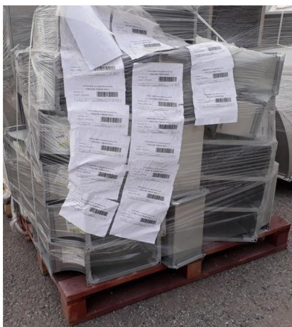
Kuva 4: Ohutlevykanavalava muovitettuna. Kun kelmun avaa, ohutlevykanavat eivät pysy enää lavassa.
