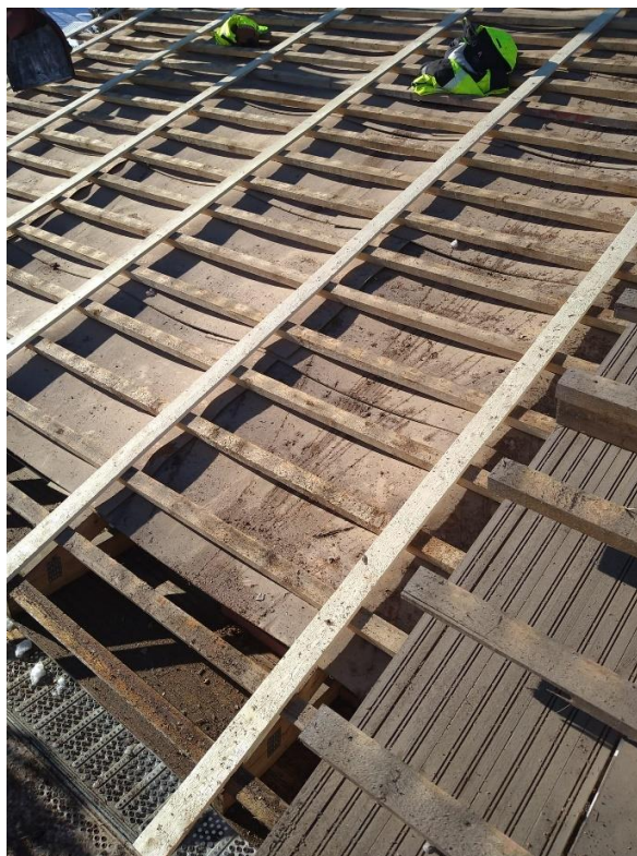
Kuva 11. Tuuletusrima vanhojen ruoteiden päällä.
