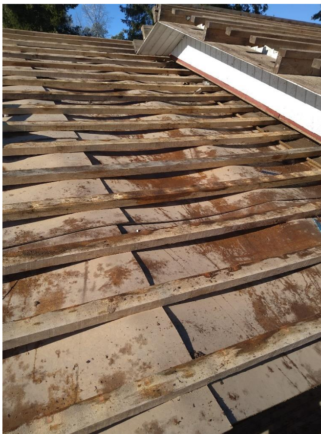
Kuva 10. Kattorakenne tiilikatteen purun jälkeen.
