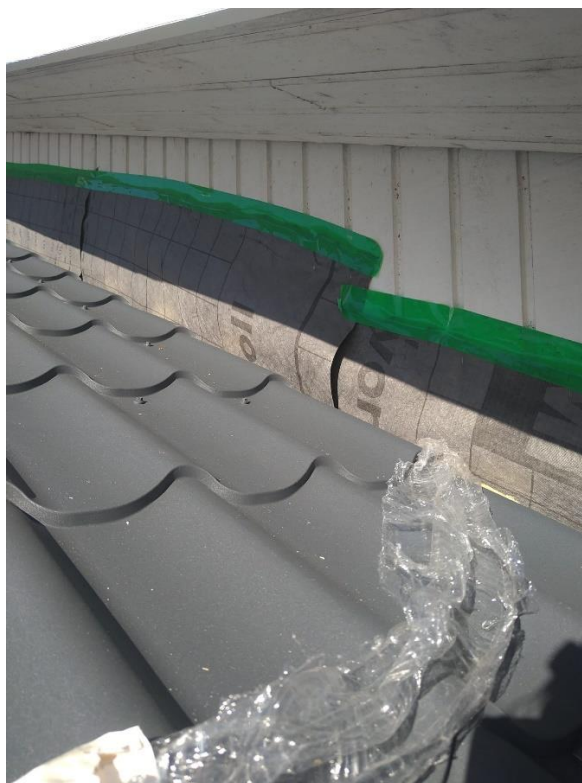
Kuva 14. Aluskatteen seinälle nosto ennen pellitystä.
