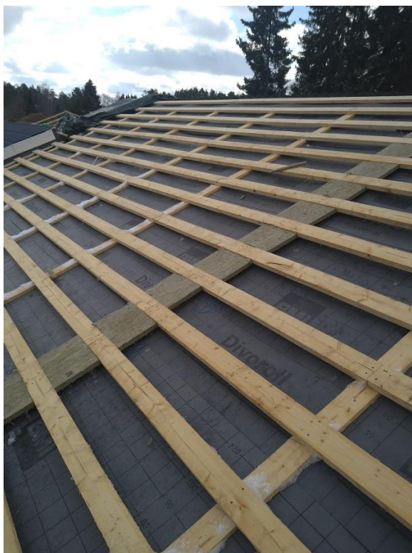
Kuva 9. Paroc Firesafe -palokatkovilla asennettuna.
