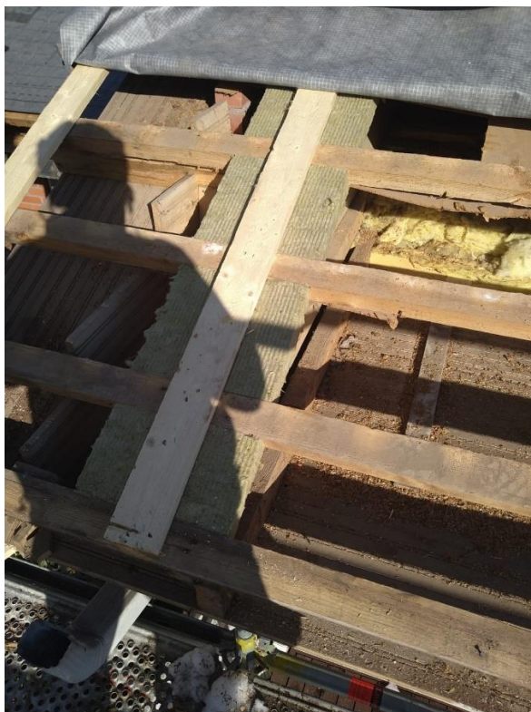
Kuva 8. Paroc Firesafe -palokatkovilla kattotuolin päällä.
