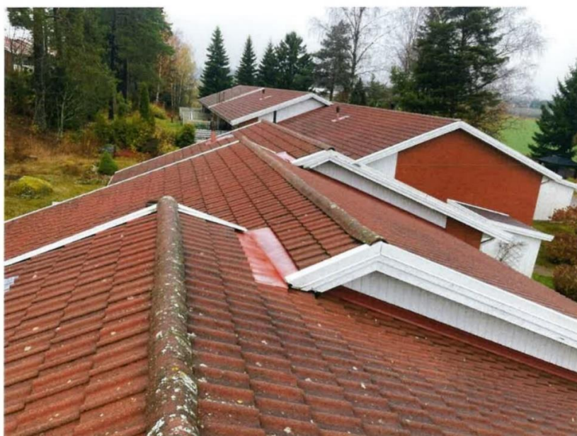
Kuva 6. Vanha tiilikate ennen remonttia.
