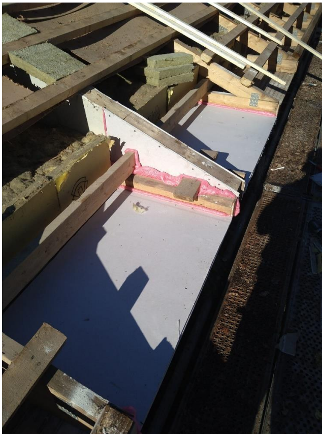
Kuva 7. Korjatut palokatkot räivastäillä.
