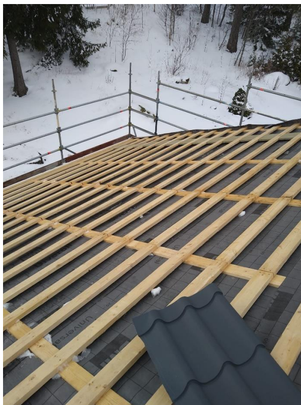
Kuva 12. Aluskate sekä tuuletusrima ja uudet ruoteet asennettuina.
