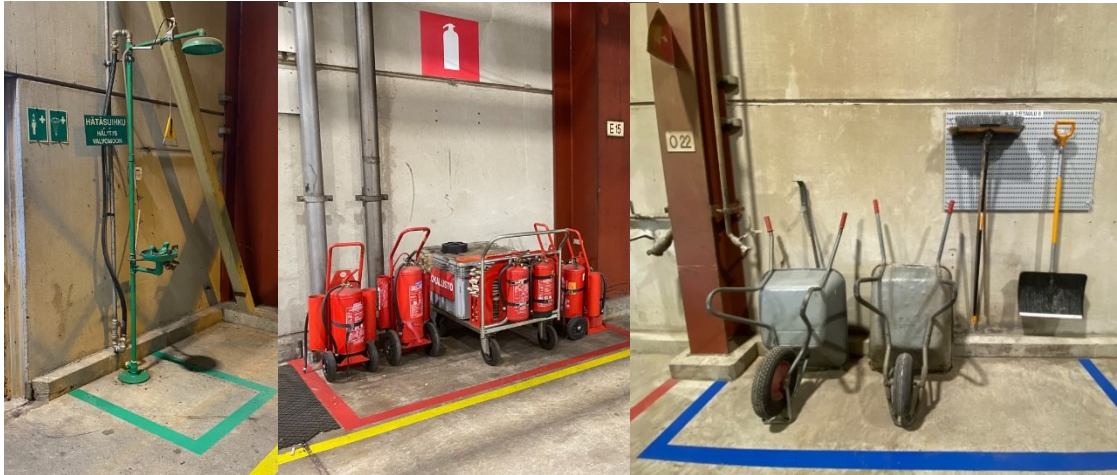
Kuva 14. Hätäsuihkun, pelastuskaluston ja materiaalipaikoituksen lattiamaalaukset. (Kuva: Olli Pihlapuro)
