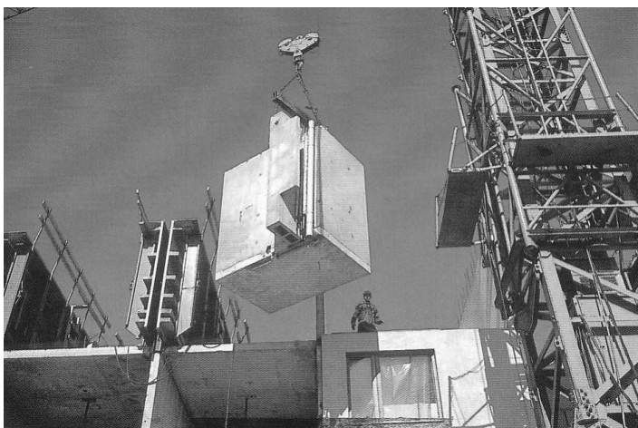
Kuva 6. Betonisen kylpyhuone-elementin nostotyö vuonna 1970. (10, s. 183).
