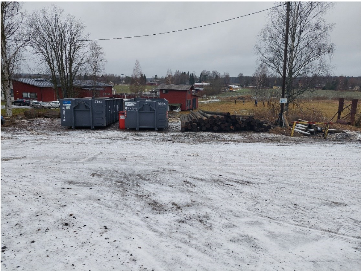
KUVA 13. Työmaan jätteiden käsittelypiste
