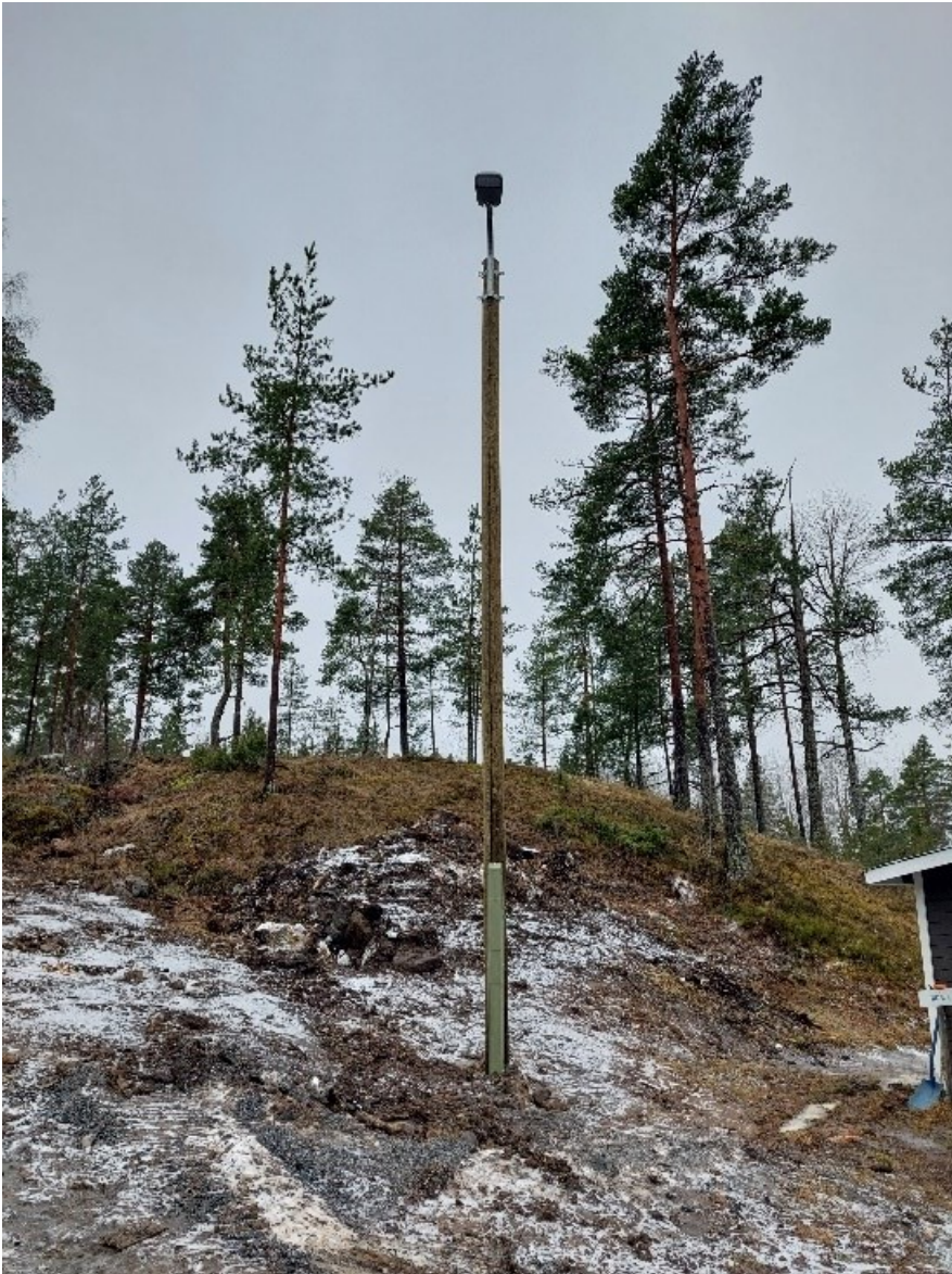
KUVA 9. Pylväs rakenne maakaapeliasennuksella
