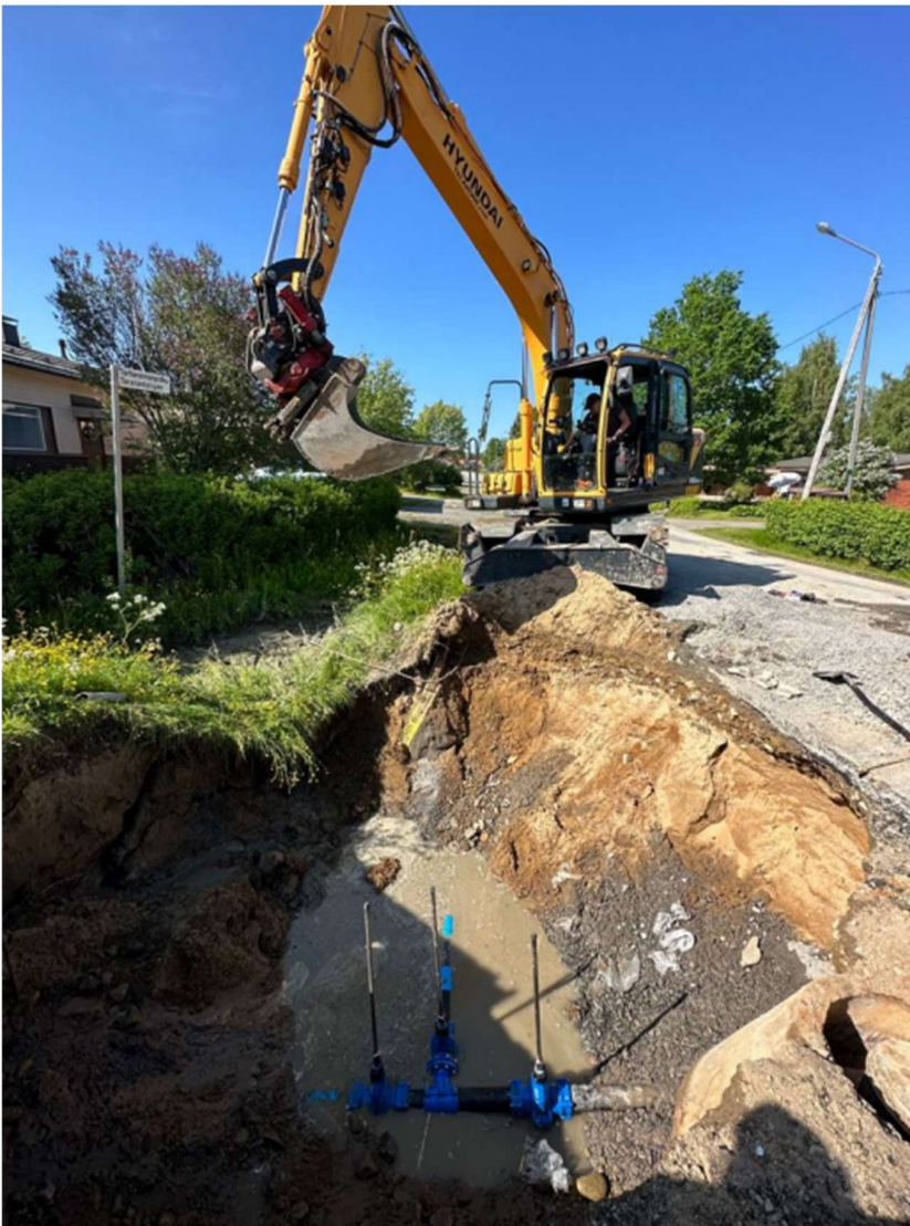
KUVA 1. Kaivantotyöt vesijohtovuodolla
