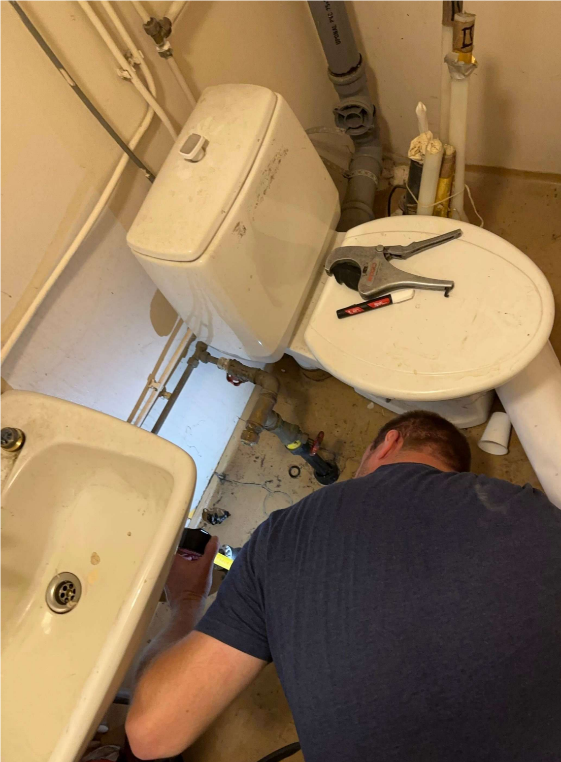
KUVA 3. Asiakkaalla kulmaventtiilin vaihto
