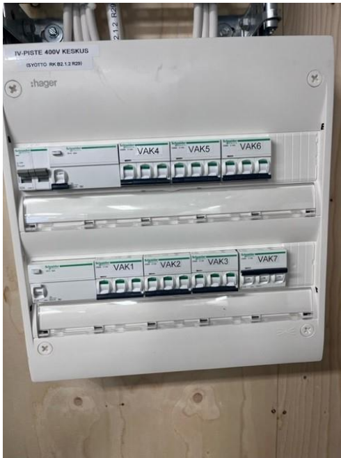
Kuva 2. 400VAC syöttökeskus.
