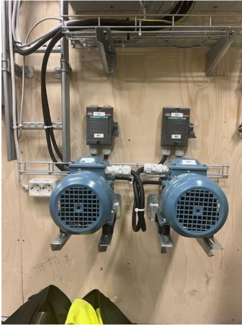
Kuva 5. Moottorien asettelu. Moottorin kaapelointi turvakytkimeltä on pysyvä.
