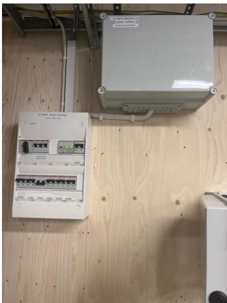
Kuva 3. 24VDC syöttökeskus sekä virtalähdekotelo.
