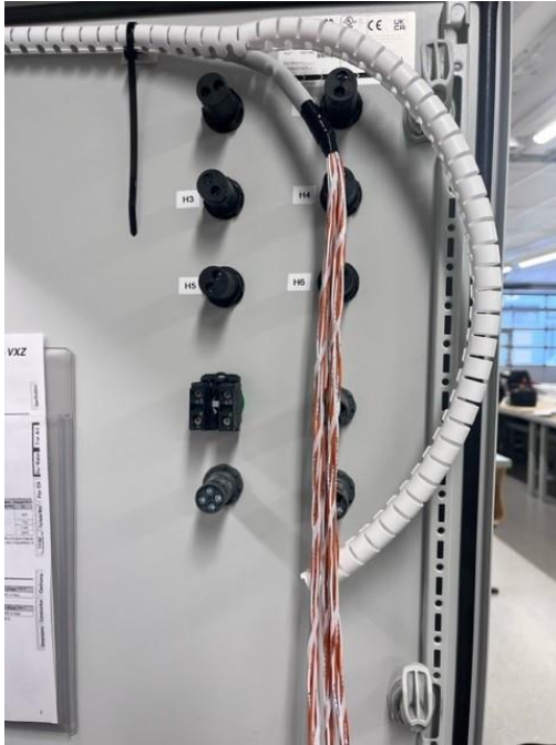
Kuva 11. NOMAK-kaapeli on suojattu spiraalilla ja kiinnitykseen käytetään liittämättä nippusideankkureita.
