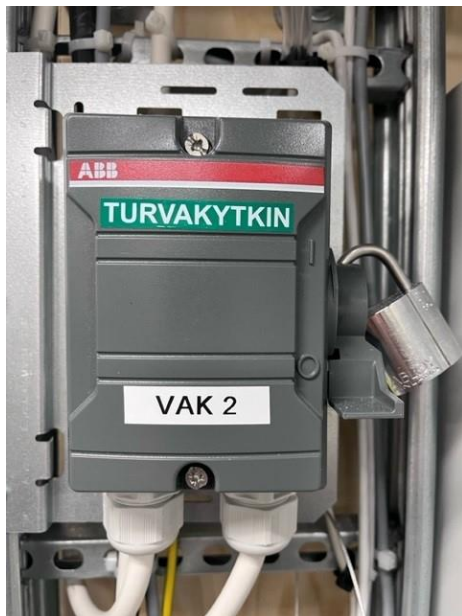
Kuva 1. Lukittu turvakytkin harjoituspisteellä.
