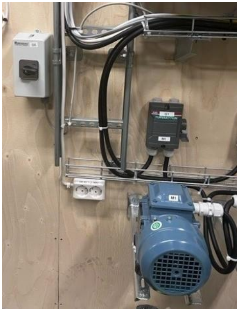
Kuva 13. 0-1-START-nokkakytkin ja moottori.
