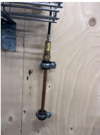
Kuva 6. Jäätymisvaara-anturi suojattuna.
