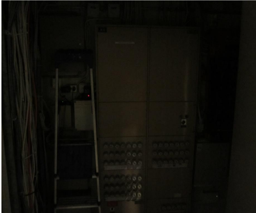
Kuva 8. Sähkökeskustila, jossa ei ole valaisinta
