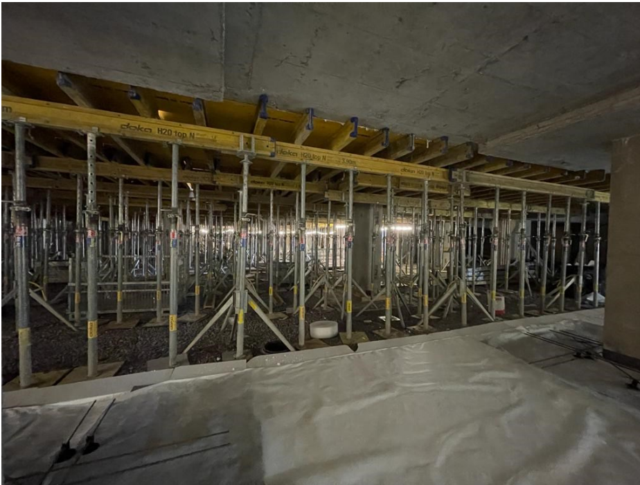
Kuva 4 Valmis muottityö holvin alapuolella.
