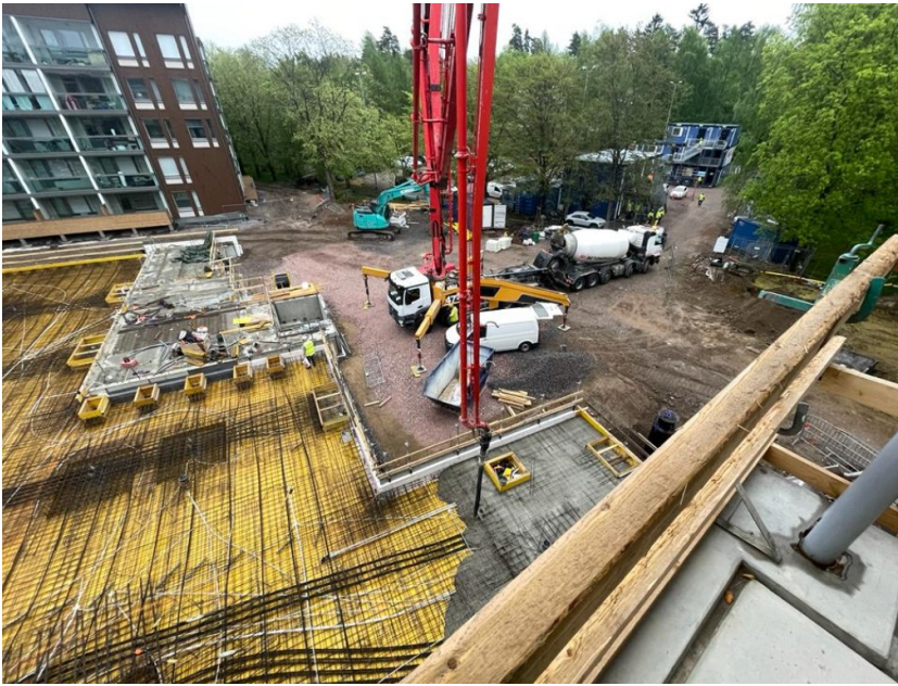
Kuva 11 Betonoinnin aloitus.
