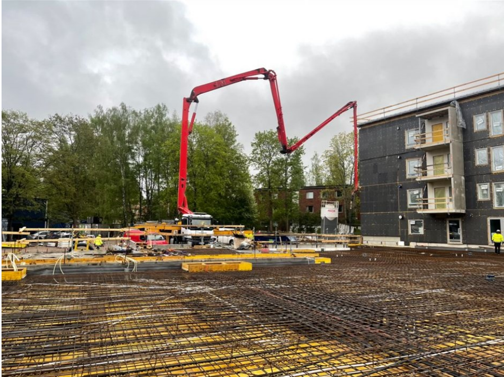
Kuva 10 Pystytetty betonipumppuauto.
