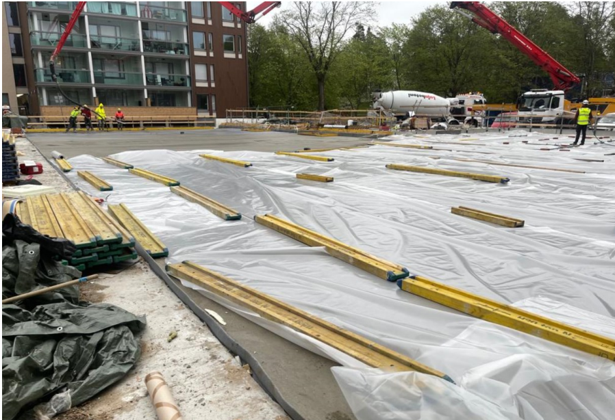
Kuva 13 Betoniholvin kastelu ja muovitus.
