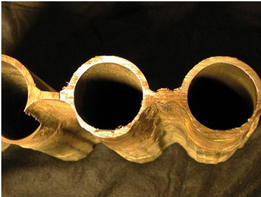
Kuva 8.1 Korroosion ohentamaa höyrytinputkistoa (Delta Test 2014).
