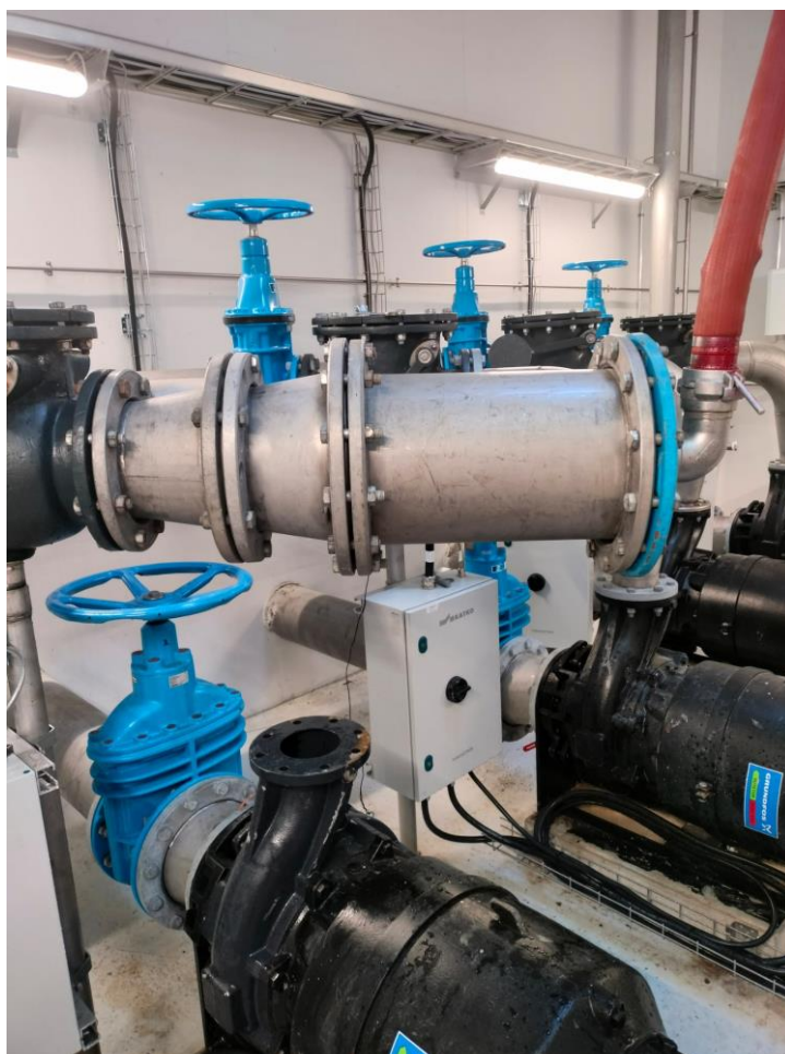
KUVA 16. Elementtipuhdistuksessa käytetty muunnoskappale (Hepola 2023)
