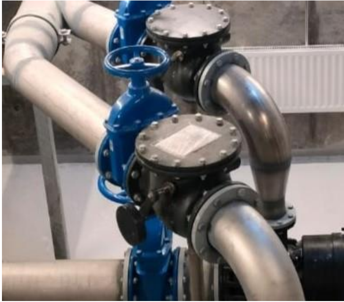
KUVA 9. Vastapainolla varustettu läppätakaiskuventtiili (Hepola 2023)
