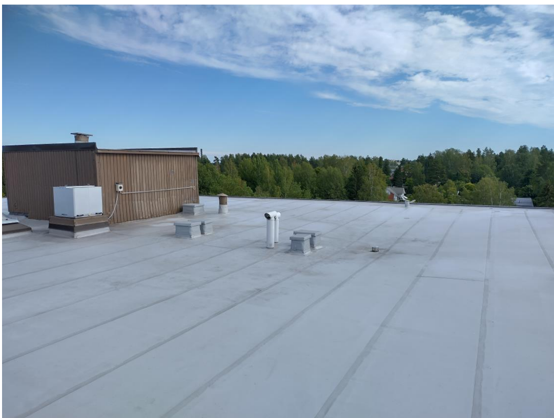
Kuva 7. Taloyhtiön A-rakennuksen katto.
