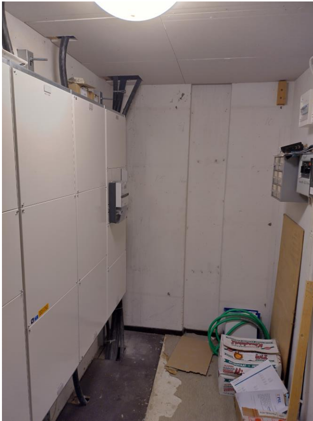
Kuva 12. Sähkötilan mahdollinen vaihtosuuntaajan paikka.
